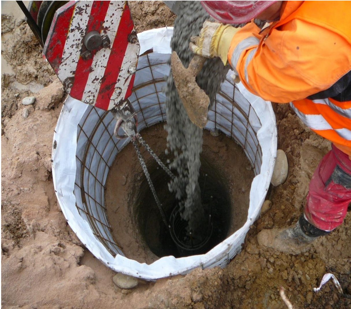
Obrázek 27: Betonáž piloty [foto autor BP]
