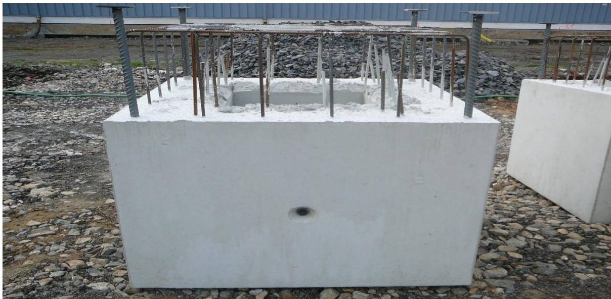
Obrázek 3: Prefabrikovaná patka dovezená na stavbu [foto autor BP]
