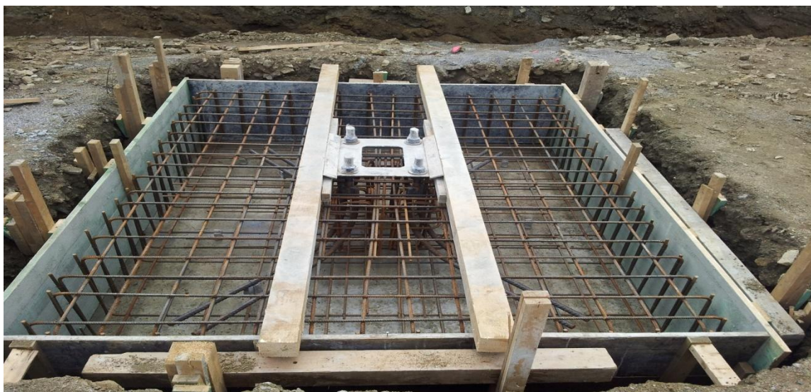
Obrázek 1: Monolitická patka před betonáží [foto autor BP]
