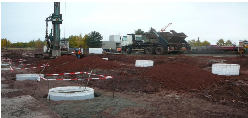
Obrázek 23: Vrtná souprava s nástavcem pro vrtání hlavice piloty [foto autor BP]
