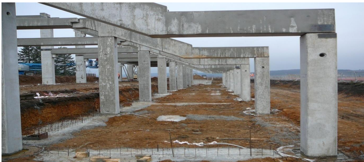
Obrázek 4: Základové pasy mezi pilotami [foto autor BP]
