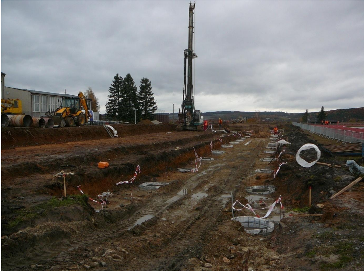
Obrázek 6: Vrtané velkopřůměrové piloty [foto autor BP]
