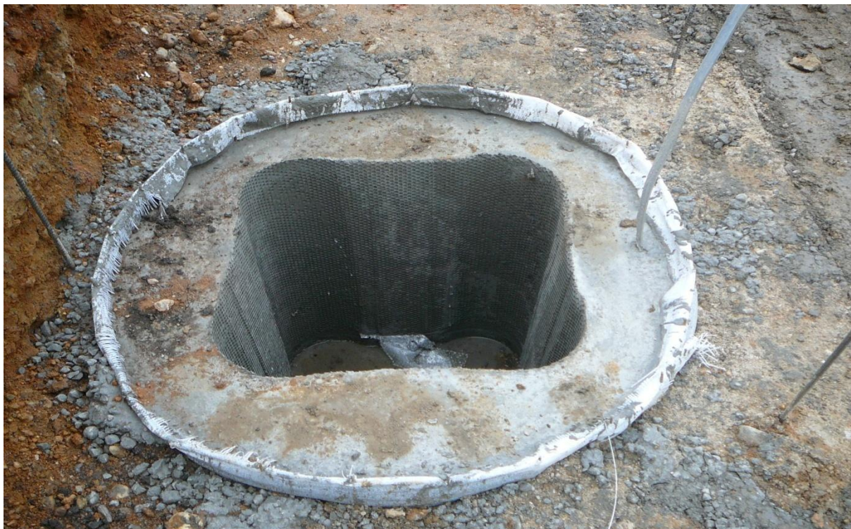
Obrázek 30: Zabetonovaná hlavice s kalichem [foto autor BP]
