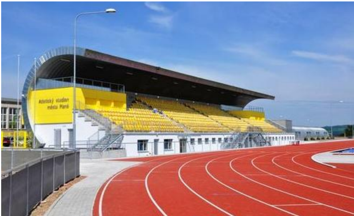
Obrázek 10: Pohled na dokončenou tribunu atletického stadionu [11]
