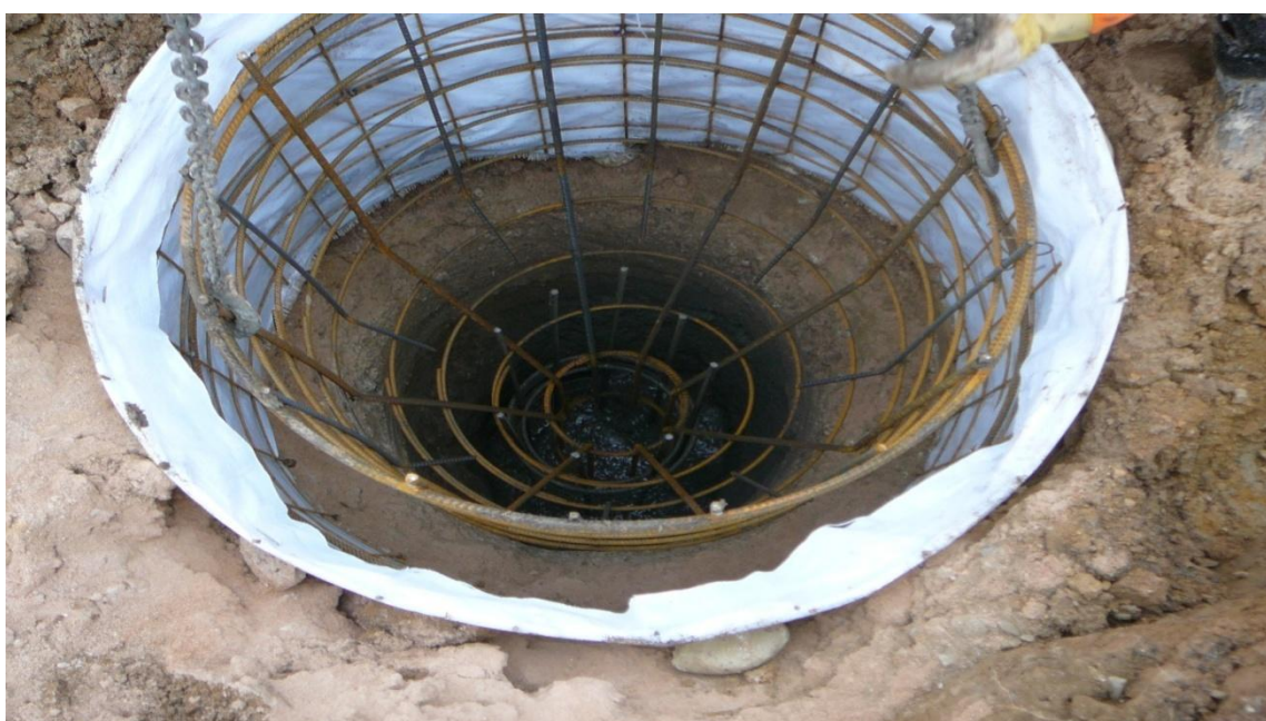
Obrázek 26: Osazování armokoše hlavice piloty [foto autor BP]
