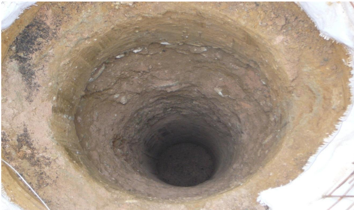
Obrázek 24: Vyvrtaná pilota před osazením výztuže [foto autor BP]
