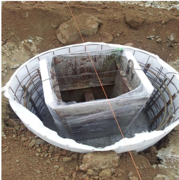
Obrázek 29: Hlavice piloty před betonáží [foto autor BP]
