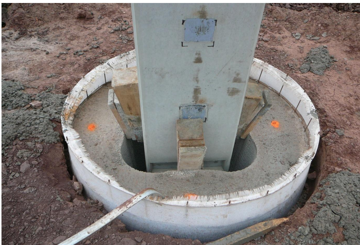
Obrázek 31: Osazený sloup v kalichu hlavice [foto autor BP]
