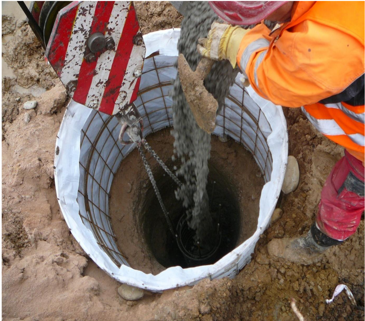
Obrázek 27: Betonáž piloty [foto autor BP]
