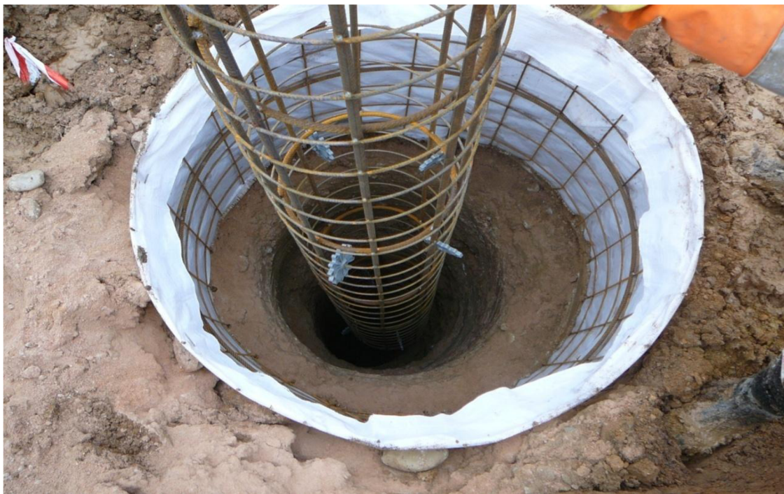
Obrázek 25: Osazování armokoše piloty s distančními prvky [foto autor BP]
