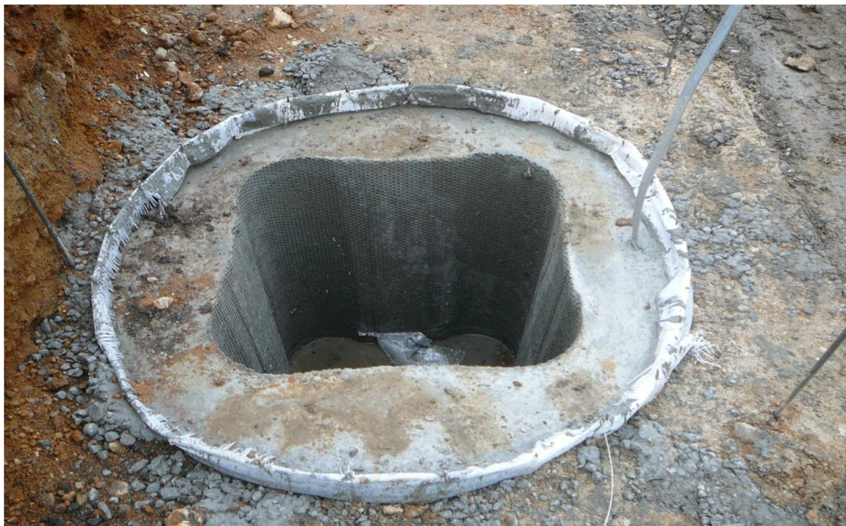
Obrázek 30: Zabetonovaná hlavice s kalichem [foto autor BP]
