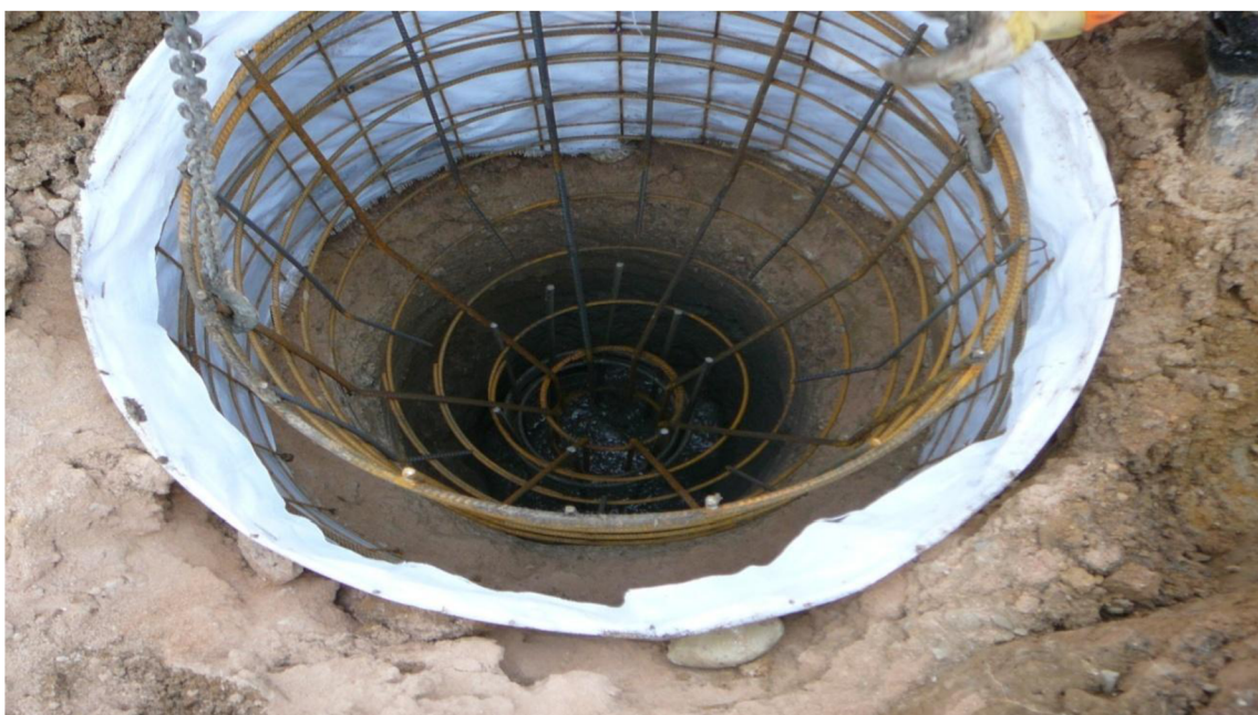
Obrázek 26: Osazování armokoše hlavice piloty [foto autor BP]
