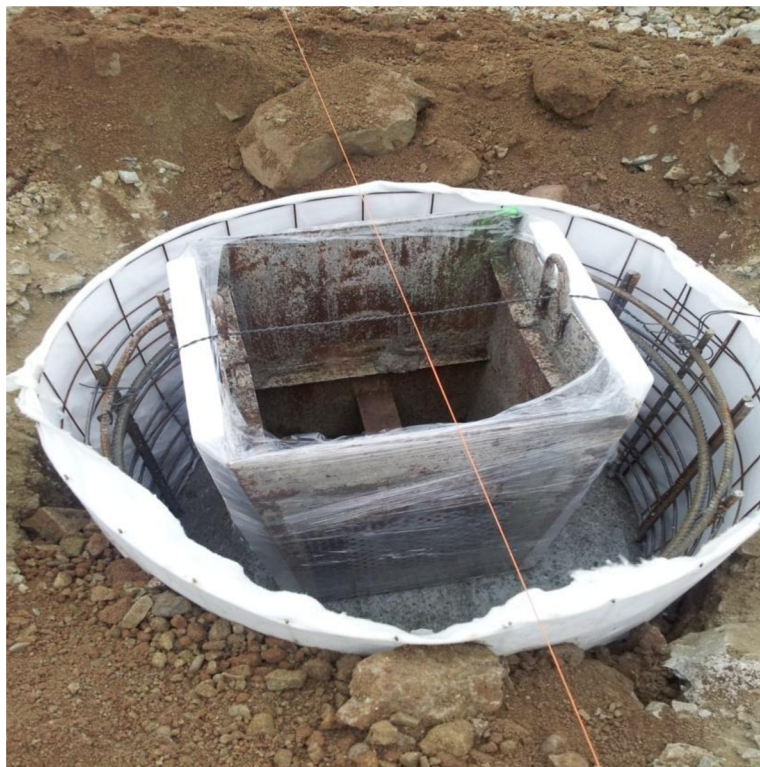
Obrázek 29: Hlavice piloty před betonáží [foto autor BP]
