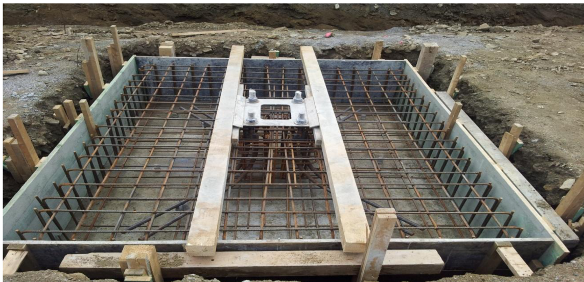
Obrázek 1: Monolitická patka před betonáží [foto autor BP]
