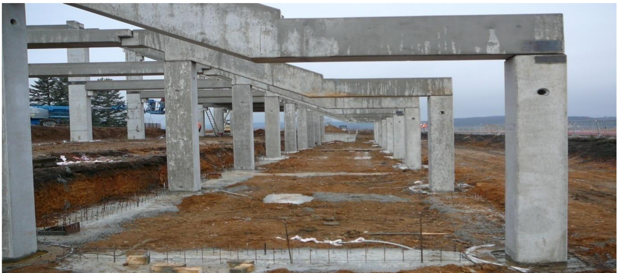
Obrázek 4: Základové pasy mezi pilotami [foto autor BP]
