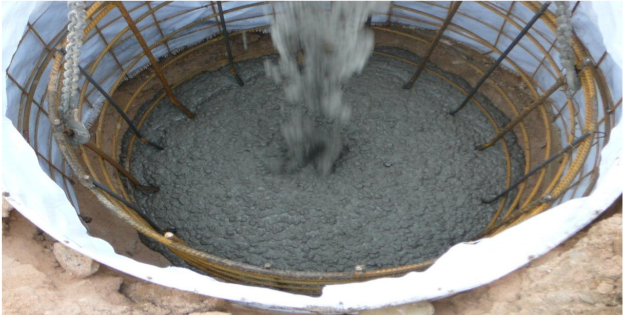
Obrázek 28: Betonáž piloty na úroveň pracovní spáry [foto autor BP]
