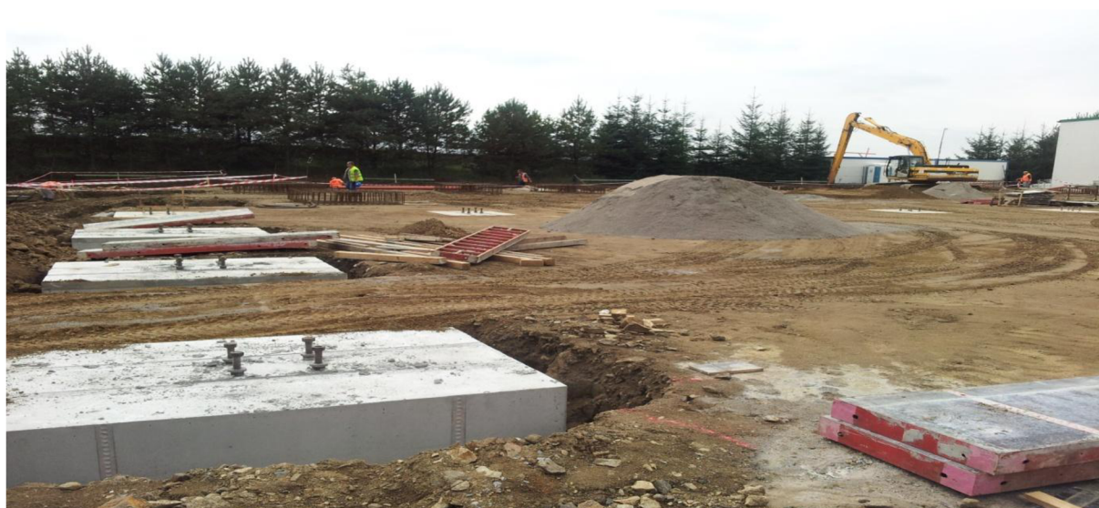
Obrázek 2: Monolitická patky již po betonáží [foto autor BP]
