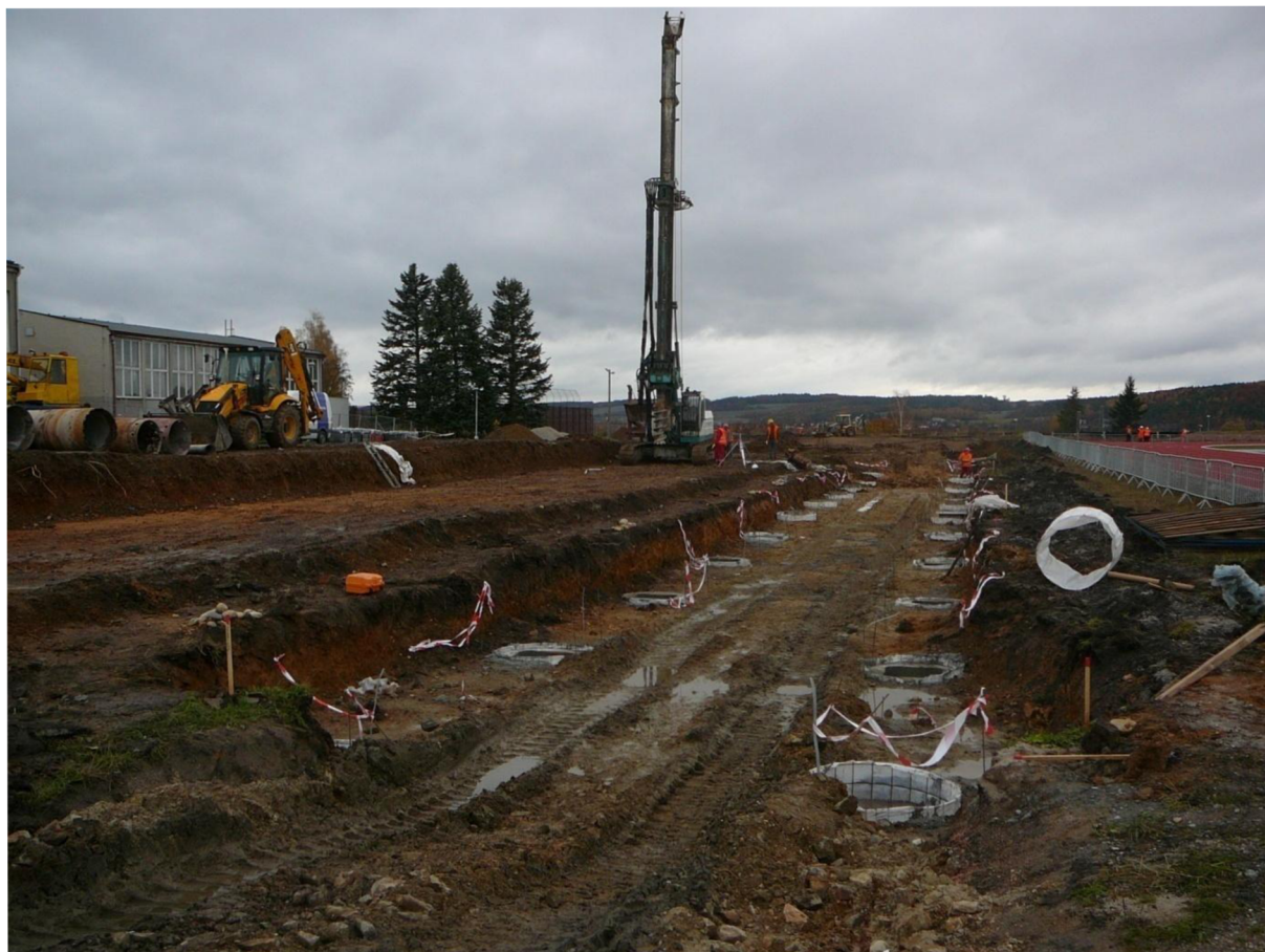
Obrázek 6: Vrtané velkopřůměrové piloty [foto autor BP]
