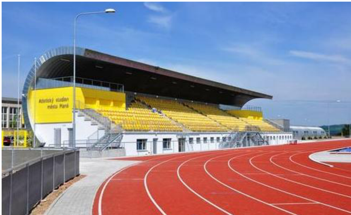
Obrázek 10: Pohled na dokončenou tribunu atletického stadionu [11]
