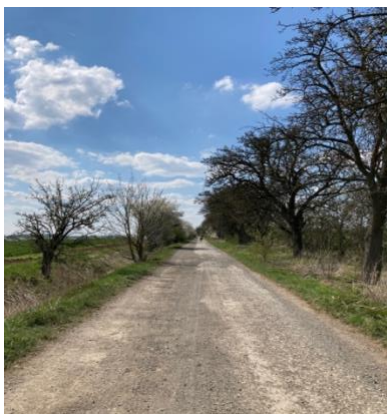
Obr. 73. Úsek cesty, na které probíhalo měření
