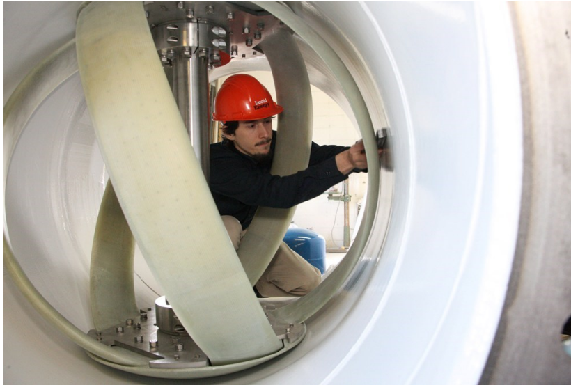
Obr. 17 - Montáž a centrování lopatek turbíny systému LPS
