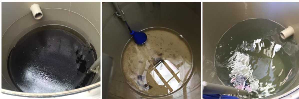
Obr. 86 Poloprovozní AnMBR - znečištění nádrže permeátu (foto autor)
