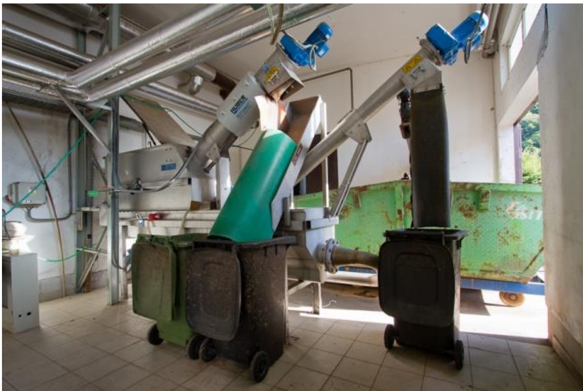
Obr. 33 ČOV Pivovar Černá Hora - mechanické předčištění (foto autor, 2013)
