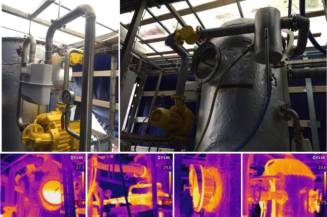
Obr. 92 Poloprovozní AnMBR - zateplení větve bioplynu (foto autor)
