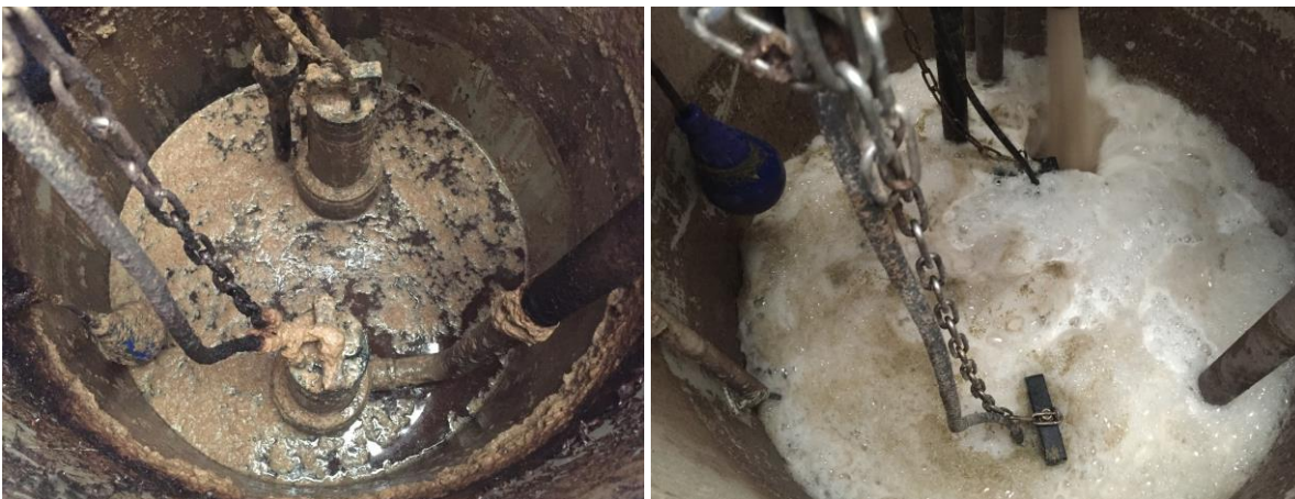
Obr. 74 Poloprovozní AnMBR - znečišťování egalizační nádrže a pění obsahu (foto autor)
