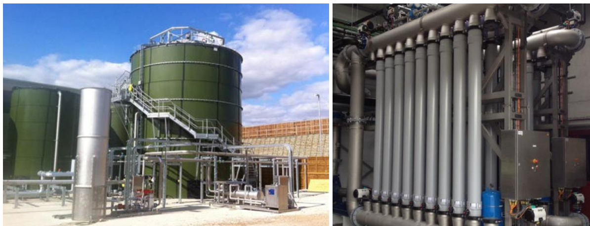
Obr. 21 Veolia Memthane – příklad a membránové moduly Pentair X-Flow [86][84]
