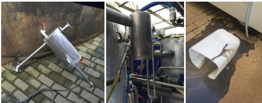
Obr. 91 Polopropozní AnMBR - nádržka kondenzátu, vnik kalu do větve bioplynu (foto autor)
