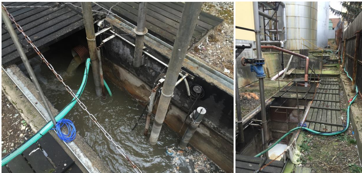
Obr. 69 Čerpací jímka, čerpání surové vody, ČOV Pivovar Černá Hora (foto autor)
