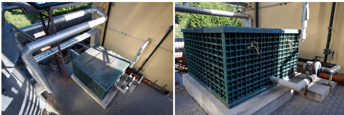
Obr. 37 ČOV Pivovar Černá Hora - dezodorační kompostový filtr (foto autor, 2013)
