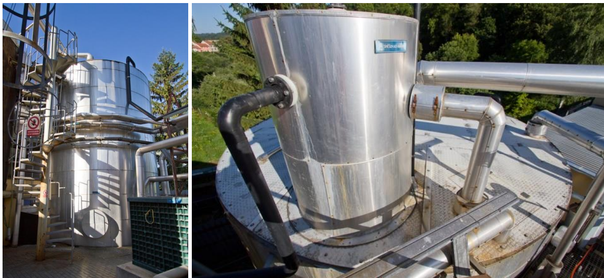
Obr. 34 ČOV Pivovar Černá Hora - acidifikační nádrž, mixtank (foto autor, 2013)
