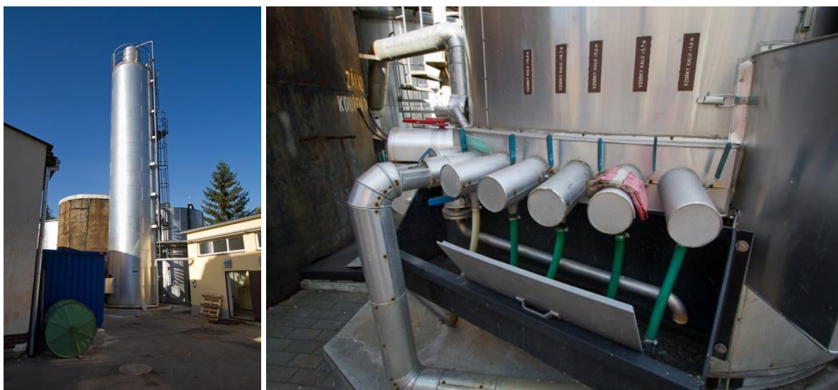
Obr. 36 ČOV Pivovar Černá Hora - IC reaktor (foto autor, 2013)
