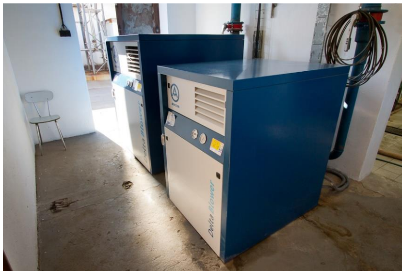
Obr. 39 ČOV Pivovar Černá Hora - dmychárna (foto autor, 2013)
