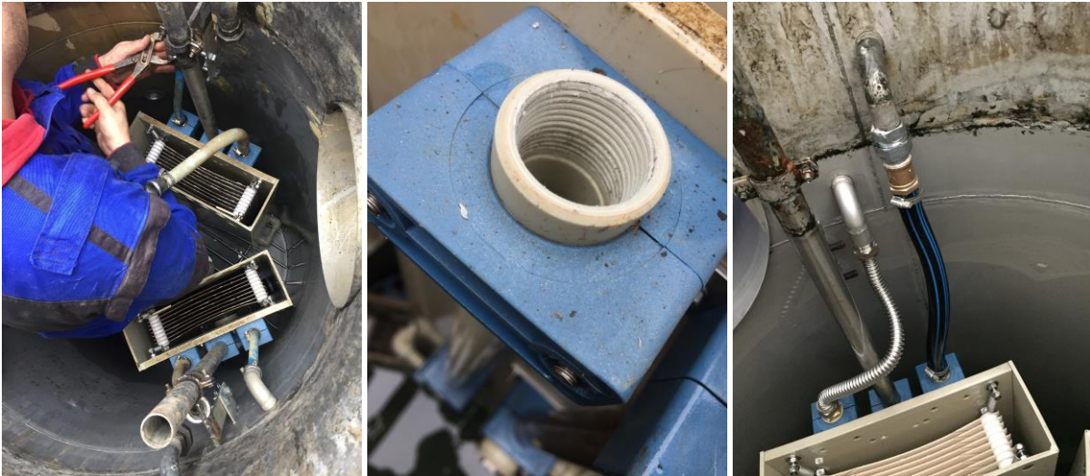
Obr. 84 Poloprovozní AnMBR - výměna hadic a přetěsnění napojení (foto autor)
