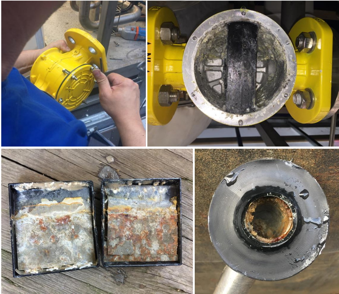
Obr. 90 Polopropozní AnMBR - čištění a přetěsnění filtru dmyhadla bioplynu (foto autor)
