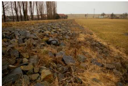
Foto 21: Návodní svah hráze [1]
