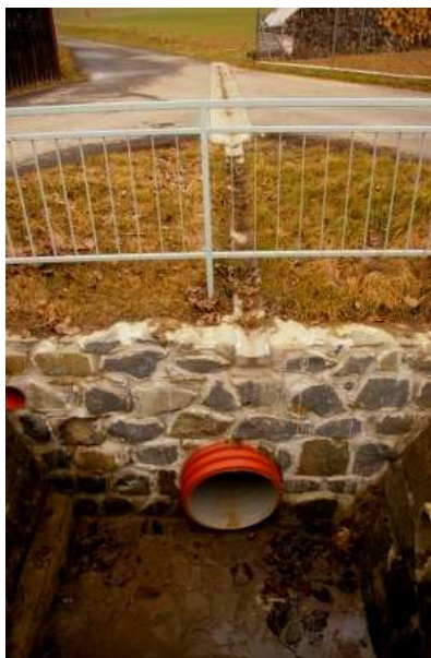
Foto 7: Vyústění zatrubnění [1]
