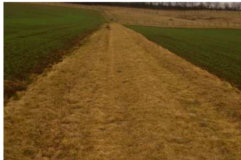
Foto 18: Zcela zanesený příkop [1]
