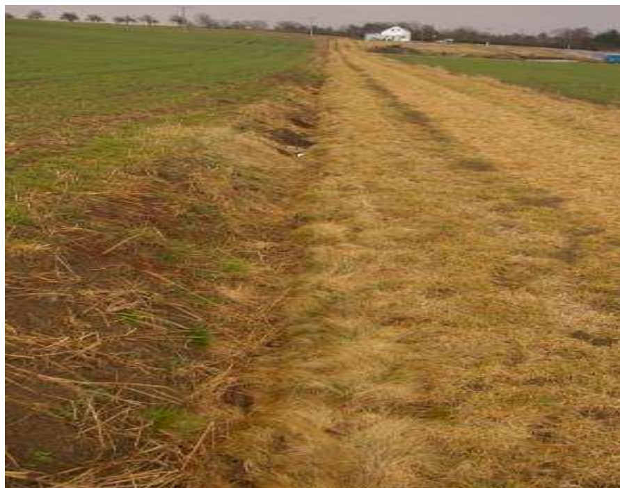
Foto 16: Zpola zanesený příkop [1]
