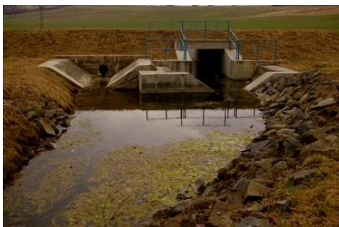
Foto 22: Vývar, spodní výpust [1]
