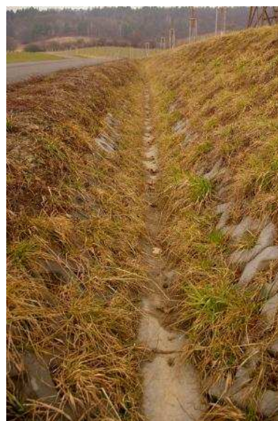
Foto 2: Opevnění koryta
