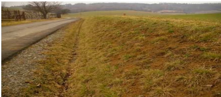
Foto 5: Opevnění koryta příkopu [1]
