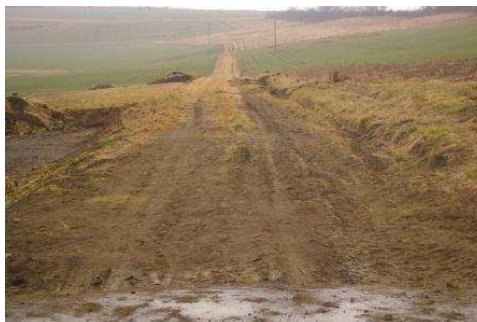
Foto 15: Erodovaná cesta s příkopem [1]
