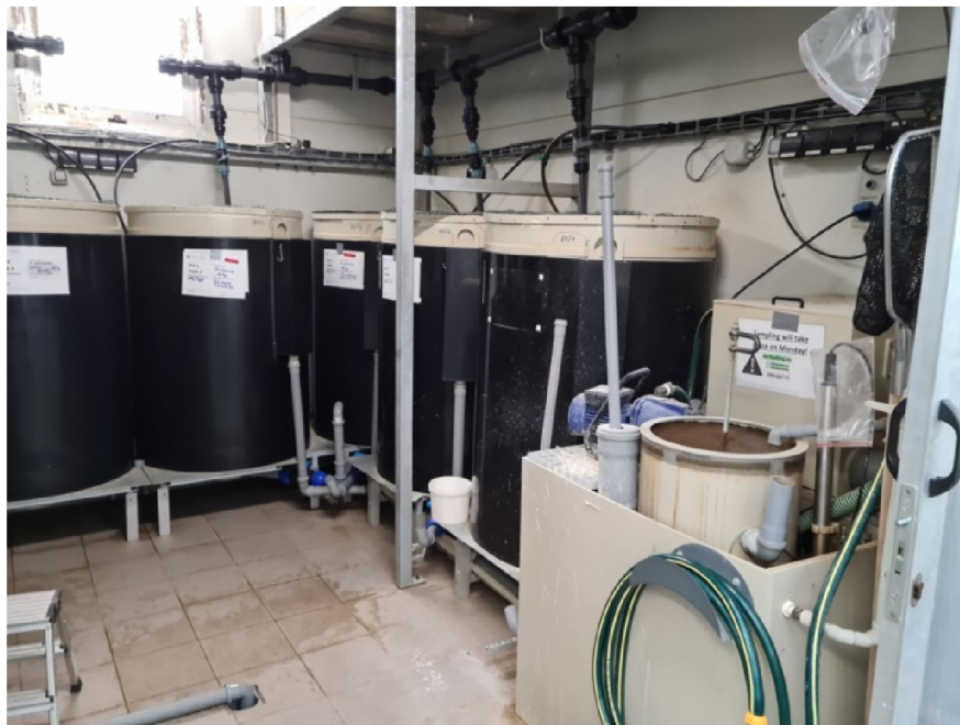
Obr. 25: Recirkulační akvakulturní systém (foto autor)
