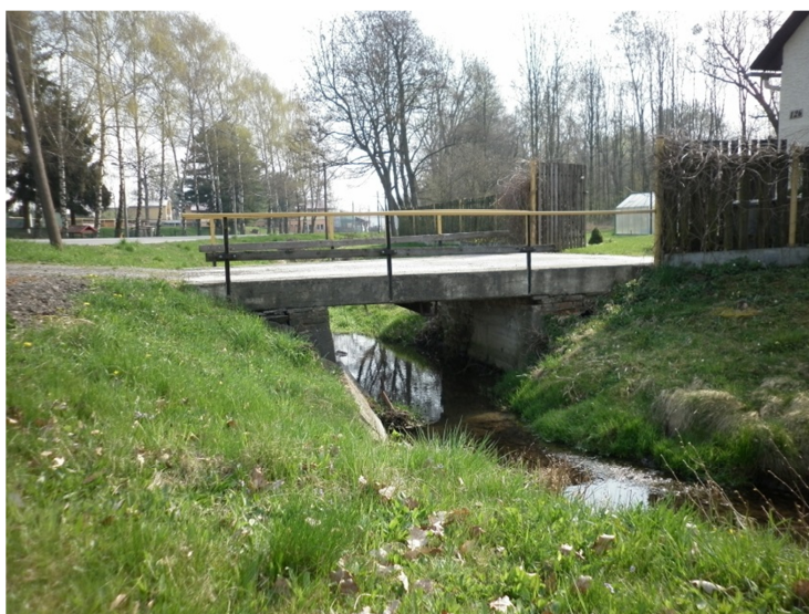
M6 silniční betonový most ř. km 2,876
