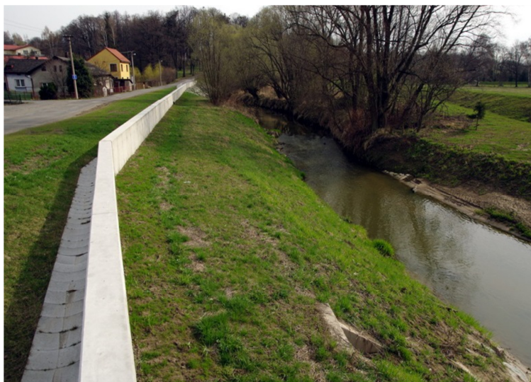
Obr. 23 Betonová ochranná zídka [3]
