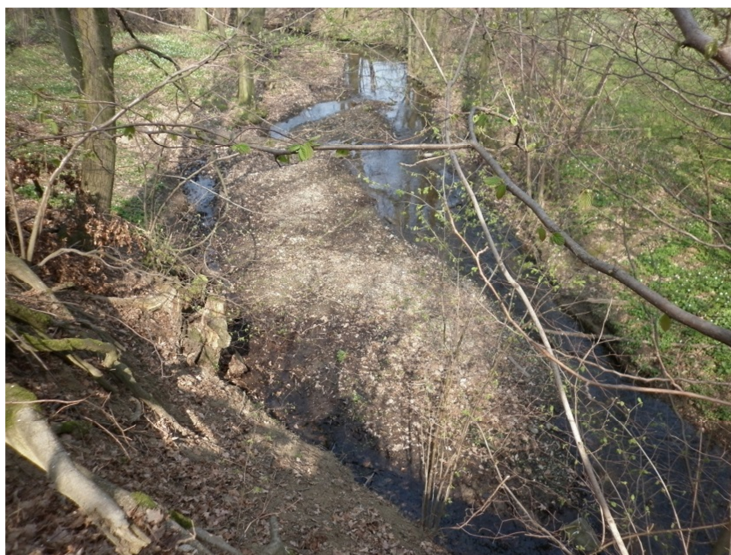
Konec řešeného úseku ř. km 4,000
