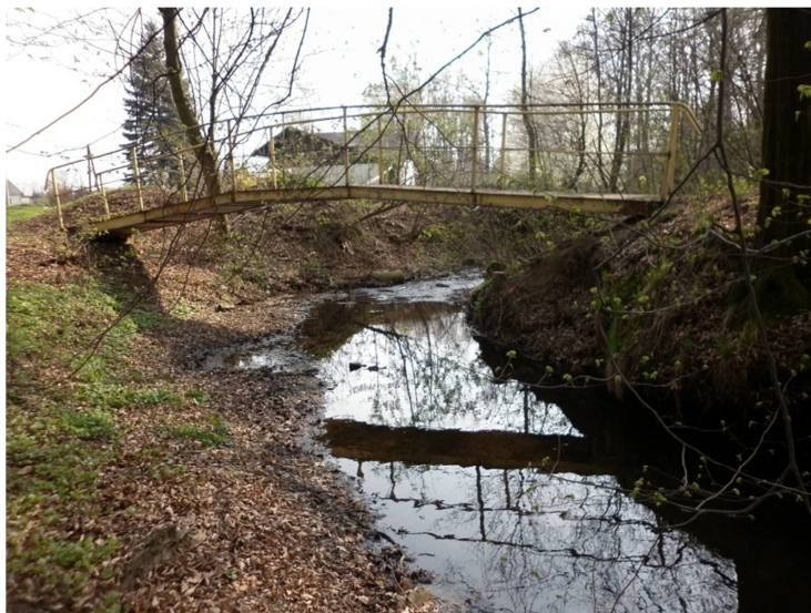
M5 ocelová lávka pro pěší ř. km 2,658
