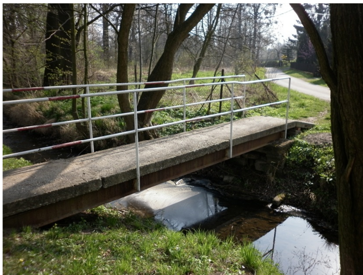
M3 ocelová lávka pro pěší ř. km 2,357
