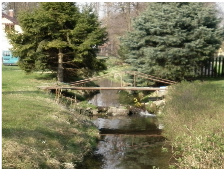
M2 ocelová lávka pro pěší ř. km 2,147
