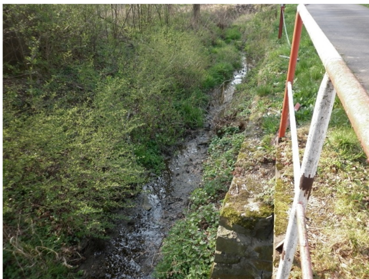
Ústí odvodňovacího kanálu ř. km 2,122
