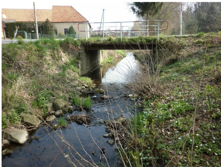
M8 silniční betonový most ř. km 3,480
