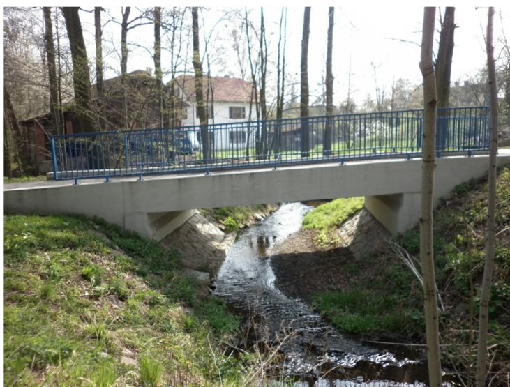
M4 silniční betonový most ř. km 2,440
