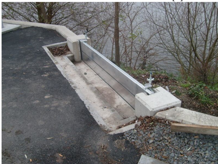
Obr. 24 Mobilní hliníkové hrazení [3]
