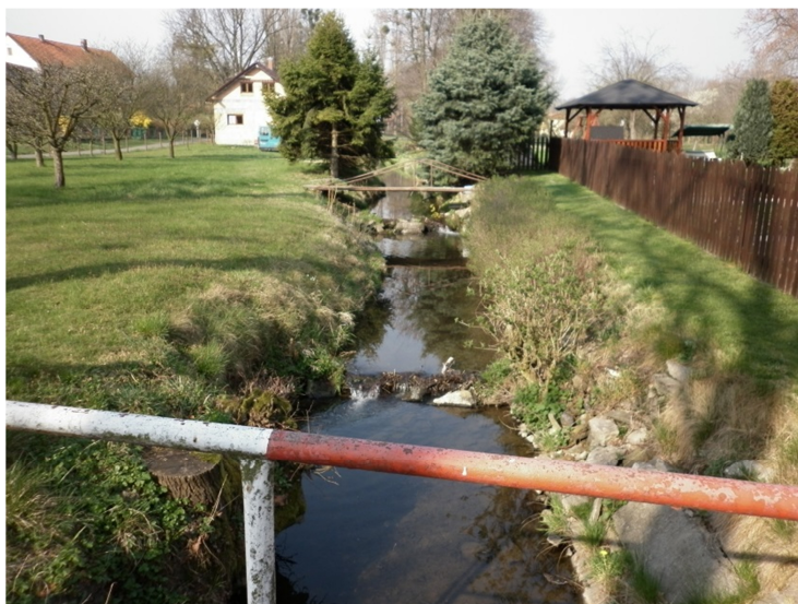
M2 ocelová lávka pro pěší ř. km 2,147
