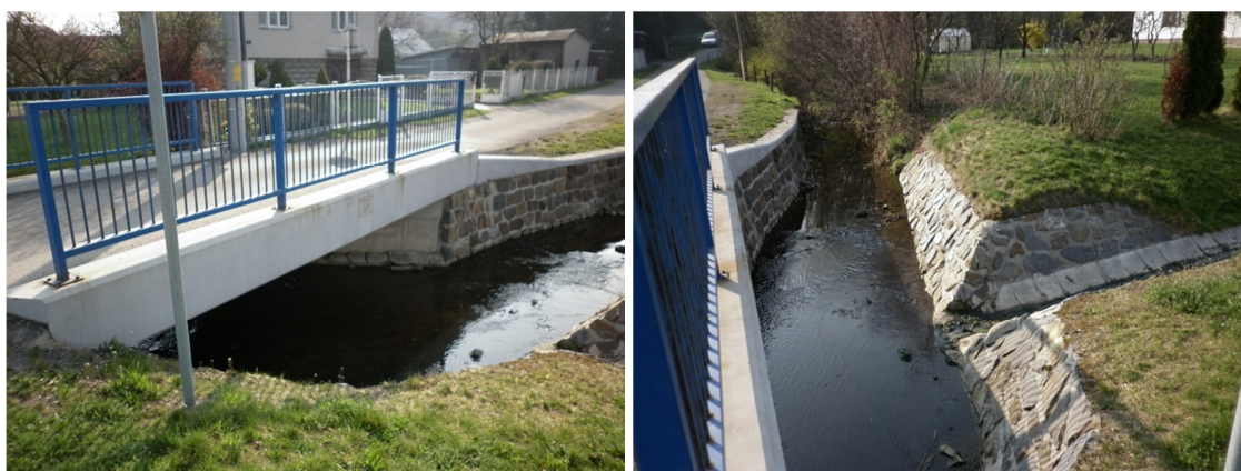
Obr. 20 Ústí umělého příkopu u Huvarova mostu [22]
