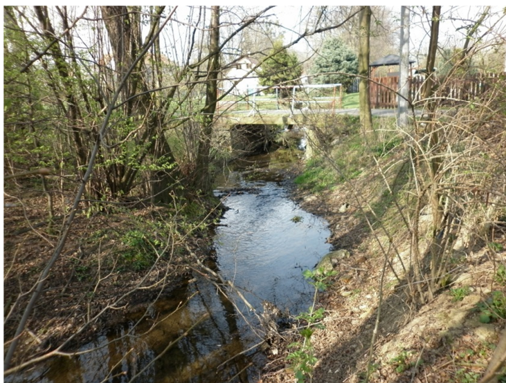
M1 silniční betonový most ř. km 2,125
