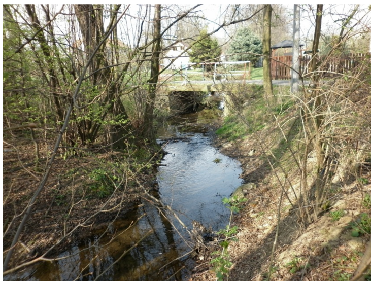
M1 silniční betonový most ř. km 2,125
