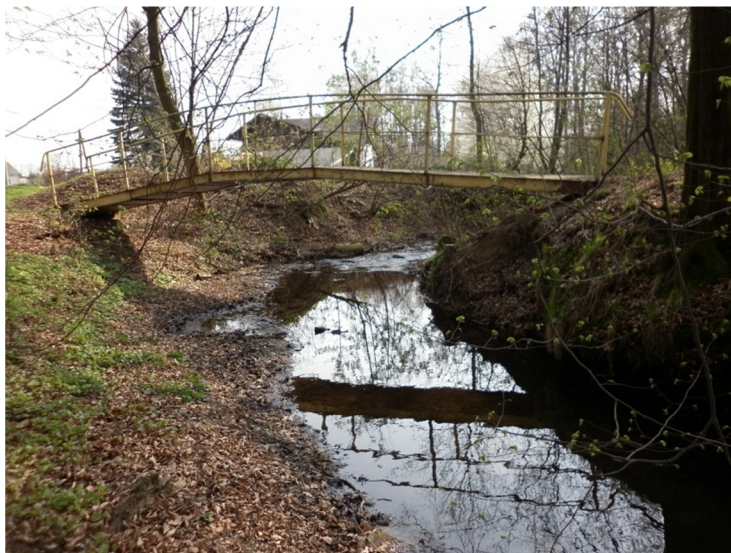
M5 ocelová lávka pro pěší ř. km 2,658
