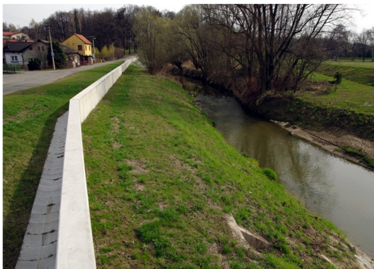
Obr. 23 Betonová ochranná zídka [3]
