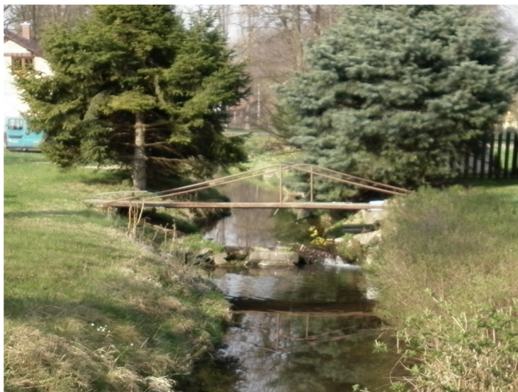
M2 ocelová lávka pro pěší ř. km 2,147
