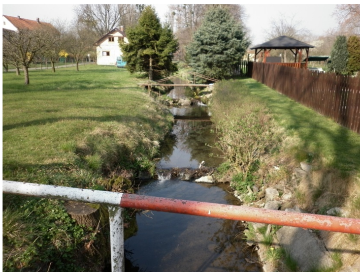
M2 ocelová lávka pro pěší ř. km 2,147
