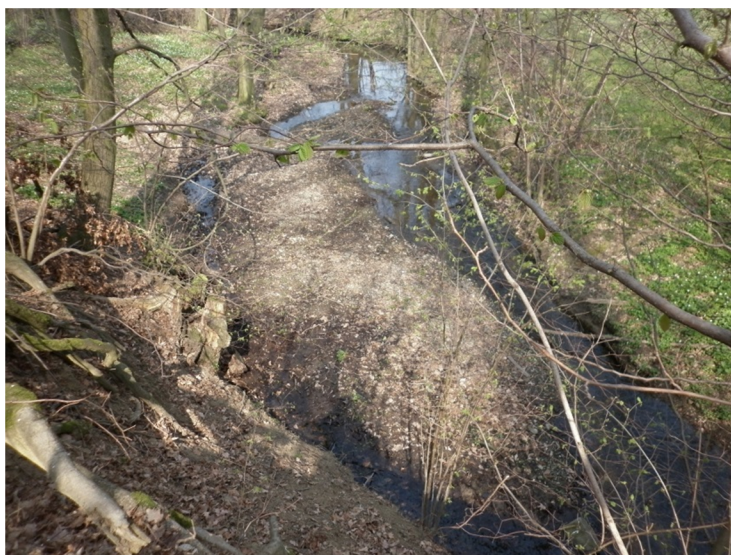
Konec řešeného úseku ř. km 4,000
