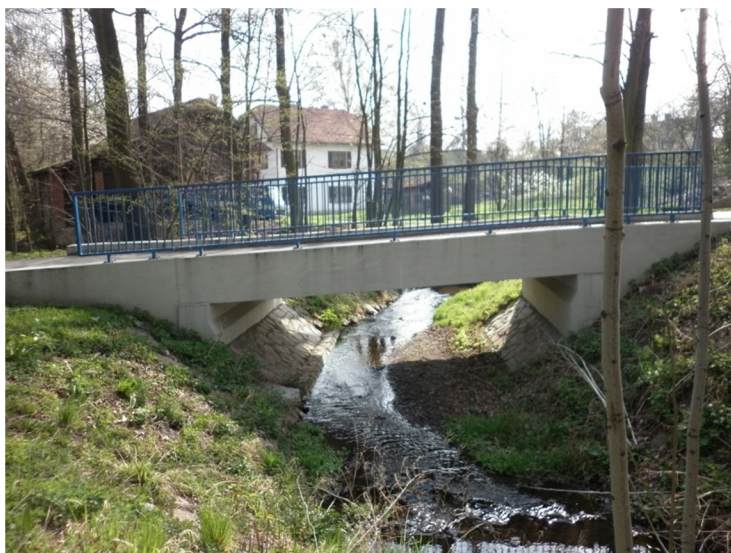
M4 silniční betonový most ř. km 2,440
