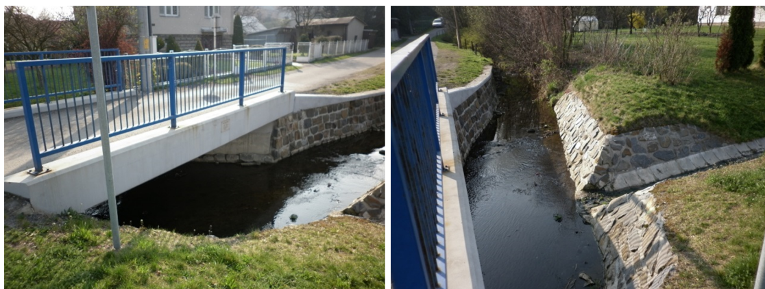
Obr. 20 Ústí umělého příkopu u Huvarova mostu [22]
