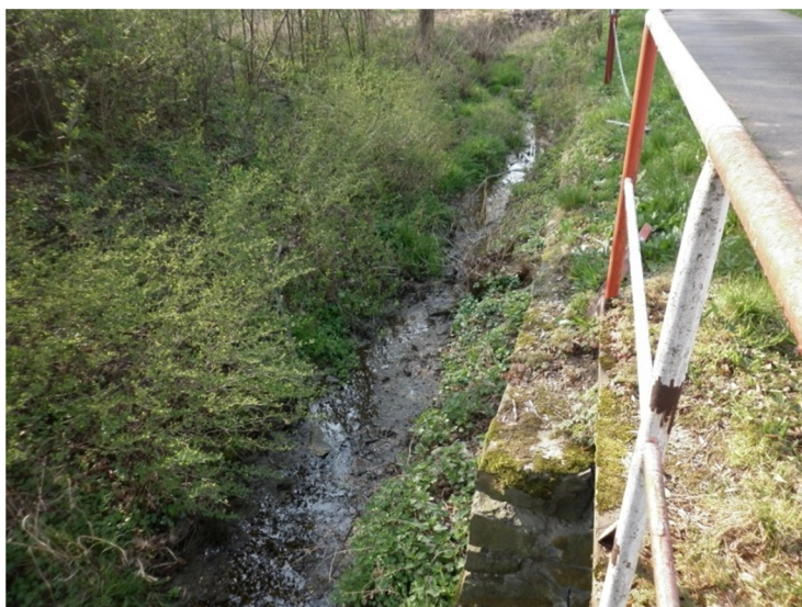
Ústí odvodňovacího kanálu ř. km 2,122
