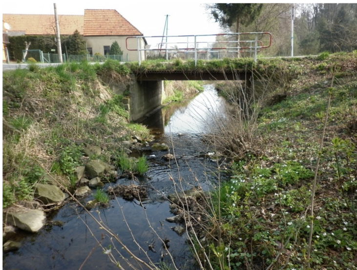
M8 silniční betonový most ř. km 3,480
