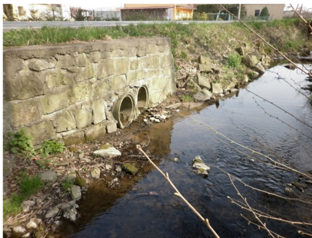
Obr. 22 Betonové vyústí [22]
