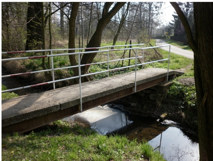
M3 ocelová lávka pro pěší ř. km 2,357
