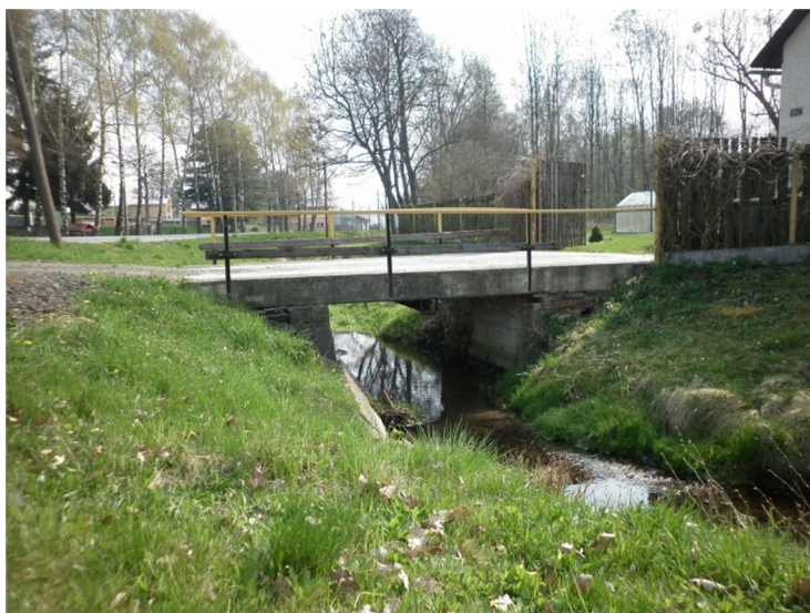
M6 silniční betonový most ř. km 2,876
