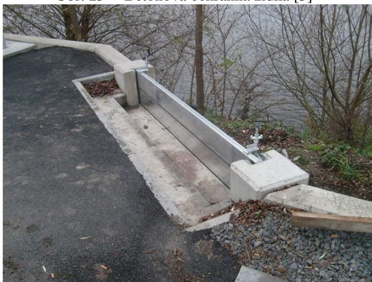
Obr. 24 Mobilní hliníkové hrazení [3]
