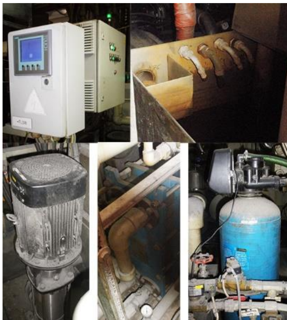
Obr. 3-3 Sekundární chladicí systém
