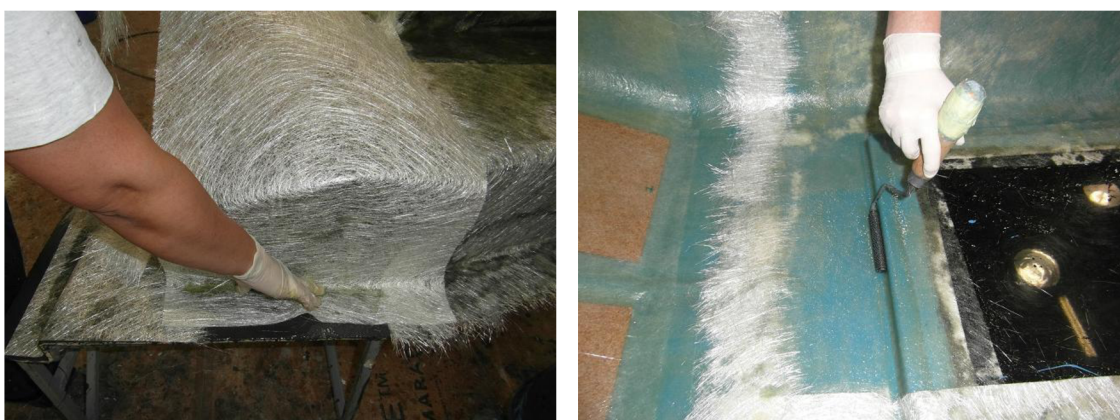
Obr. 12 Ruční laminace – zakládání skelné rohože (vlevo), válečkování (vpravo).
