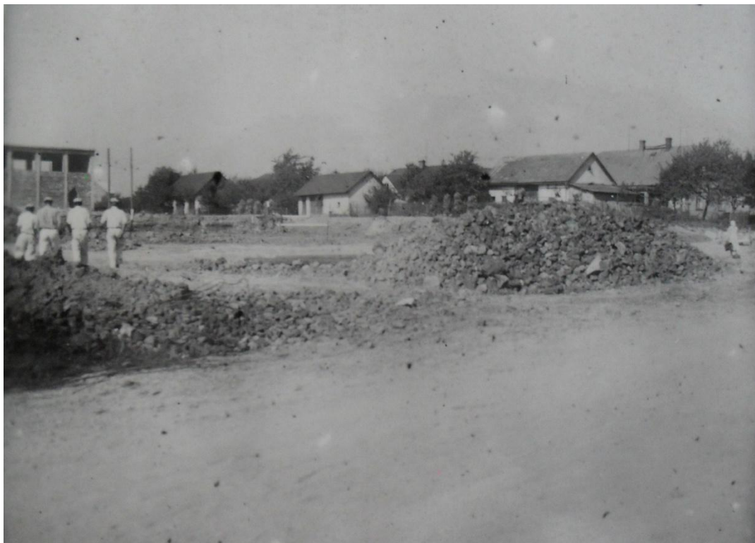
Obr. 34: Staveniště obchodních domů v roce 1959
