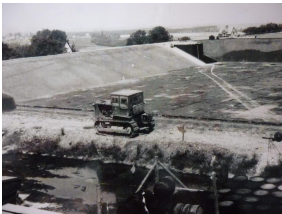
Obr. 29: Výstavba přečerpávacích nádrží na Kostelci r. 1963
