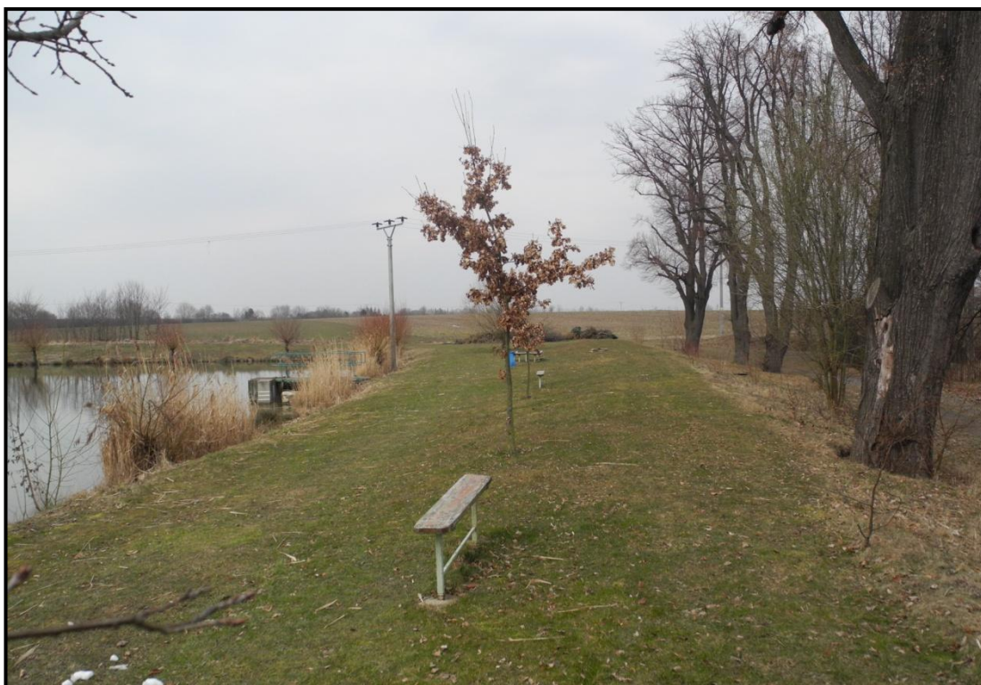
9.11. Hráz ochranné vodní nádrže na Ostrovském potoce
