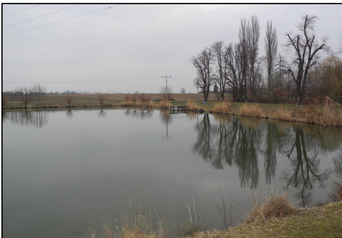
9.12. Ochranná vodní nádrž na Ostrovském potoce
