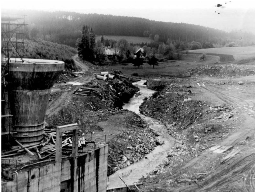
Obrázek 12: Stavba VD Lučina v roce 1973, v centrální části horní poloviny fotografie patrné původní domy
