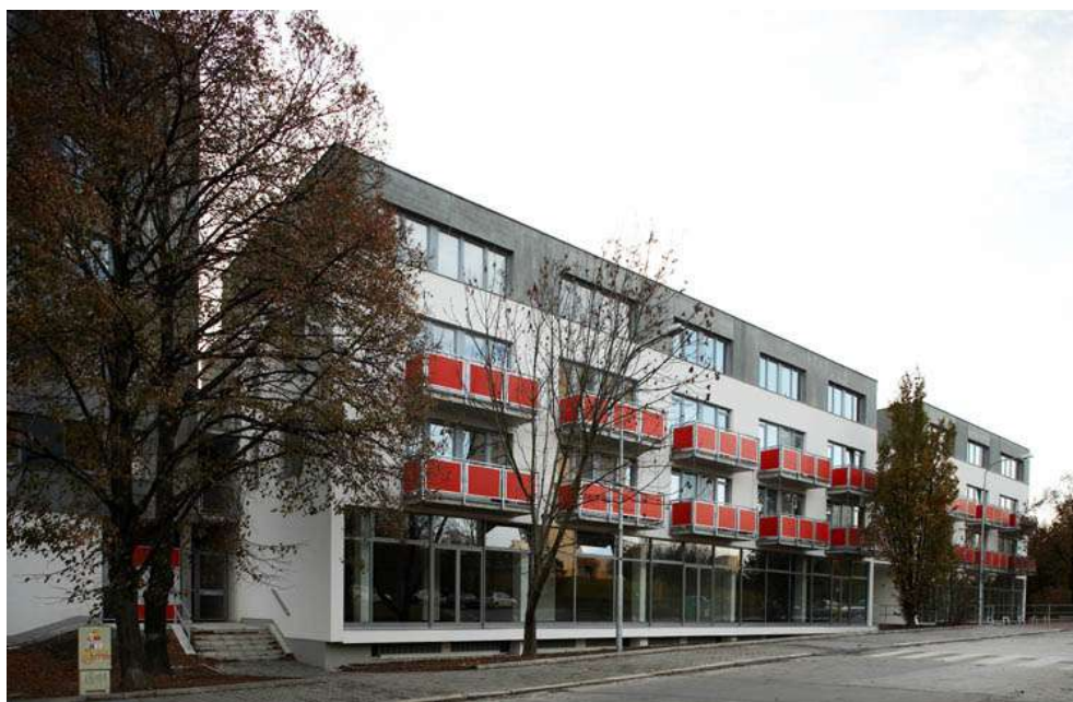
Obr. č. 33: Bytový dům Lučina, ulice Nejedlého [49]
