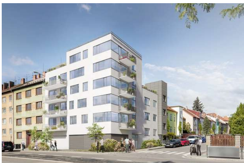
Obr. č. 31: Rezidence Merhautova Alešova [47]
