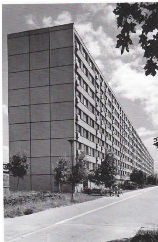
Obr. č. 25: Deskové bytové domy schodišťové, sídliště Lesná [28]
