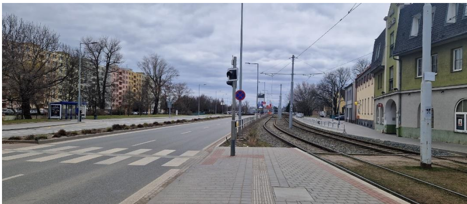
Obrázek 11 - Trať na zvláštním tělese na boku městské komunikace (ul. Svatopetrská, Brno) [vlastní]
