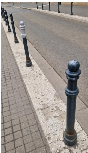
Obrázek 66 - Sloupky (zastávka Šilingrovo náměstí, Brno) [vlastní]
