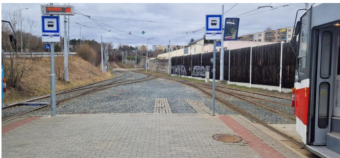
Obrázek 48 - Hlavová úvrať (zastávka Mifkova, Brno) [vlastní]
