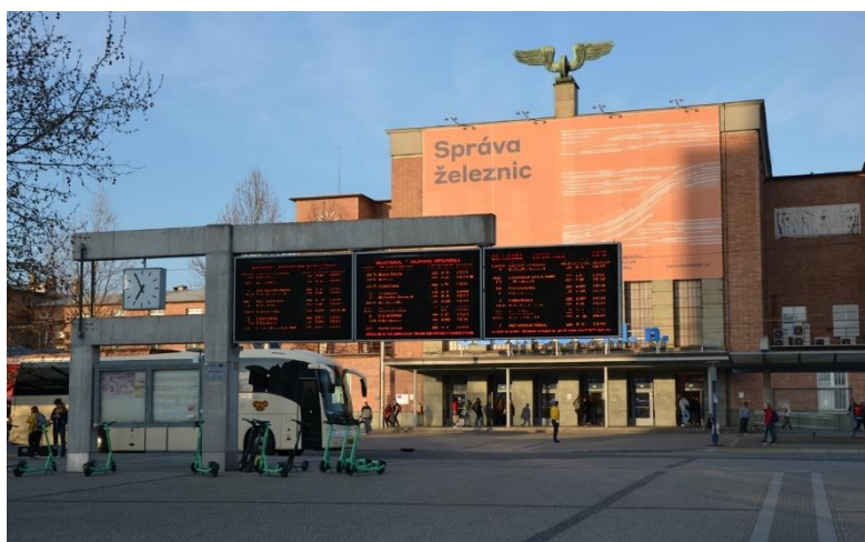
Obrázek 58 - Elektronický panel v dopravním uzlu (Hlavní nádraží, Olomouc) [vlastní]
