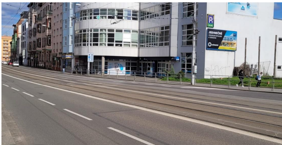
Obrázek 9 - Trať na vyvýšeném tělese v ose komunikace (ul. Milady Horákové Brno) [vlastní]
