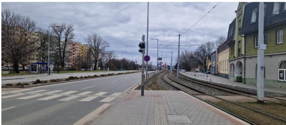
Obrázek 11 - Trať na zvláštním tělese na boku městské komunikace (ul. Svatopetrská, Brno) [vlastní]
