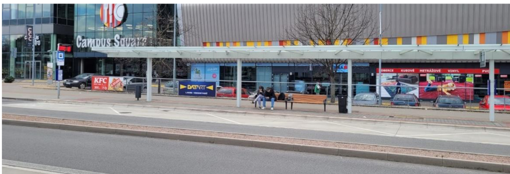
Obrázek 20 - Zastávka v jízdním pruhu s možností objíždění (Nemocnice Bohunice, Brno) [vlastní]
