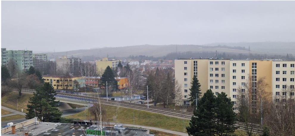
Obrázek 12 - Trať na zvláštním samostatném tělese mimo komunikaci (Starý Lískovec, Brno) [vlastní]
