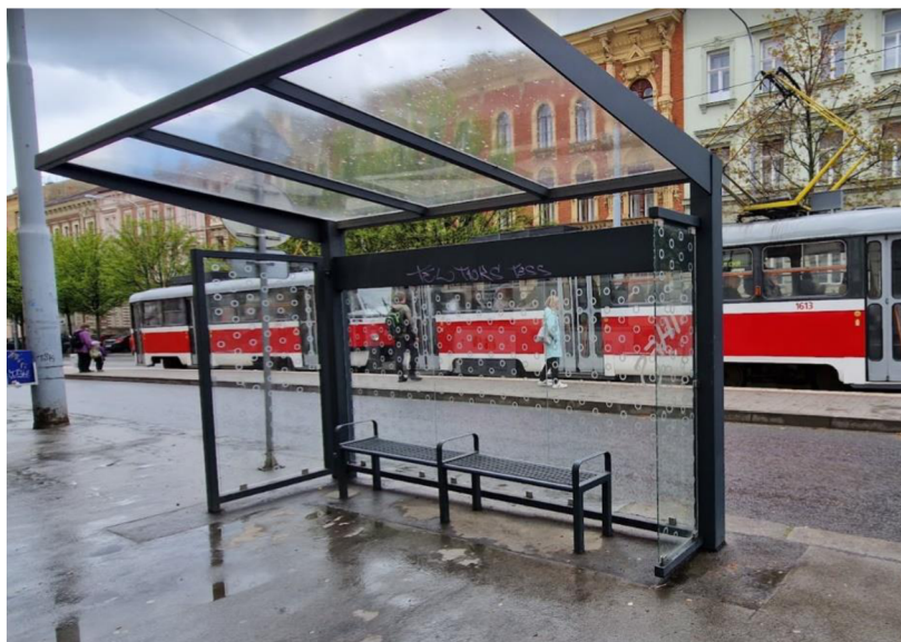
Obrázek 60 - Přístřešek s lavičkou (zastávka Grohova, Brno) [vlastní]
