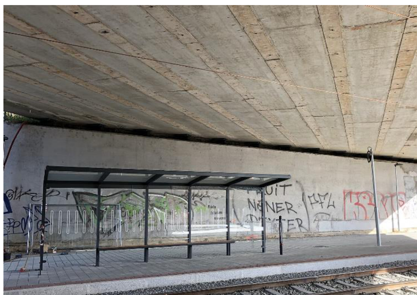
Obrázek 63 - Přístřešek pod mostem (zastávka Osová, Brno) [19]
