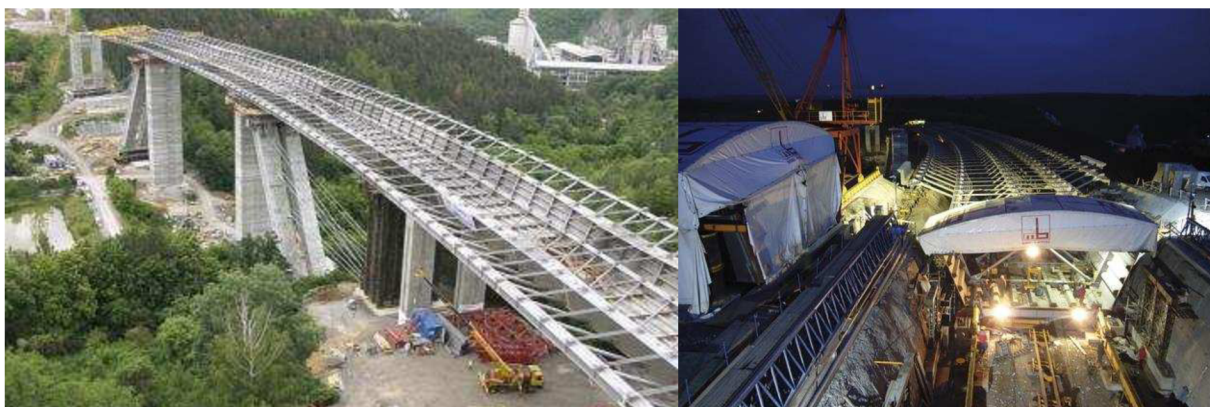
Obr. 1 Využití technologie svařování (svařování karosérie vozů Volvo koncernu Zhejiang Geely Holdings Group, svařování ocelové konstrukce mostu přes Lochkovské údolí) [12], [33]
