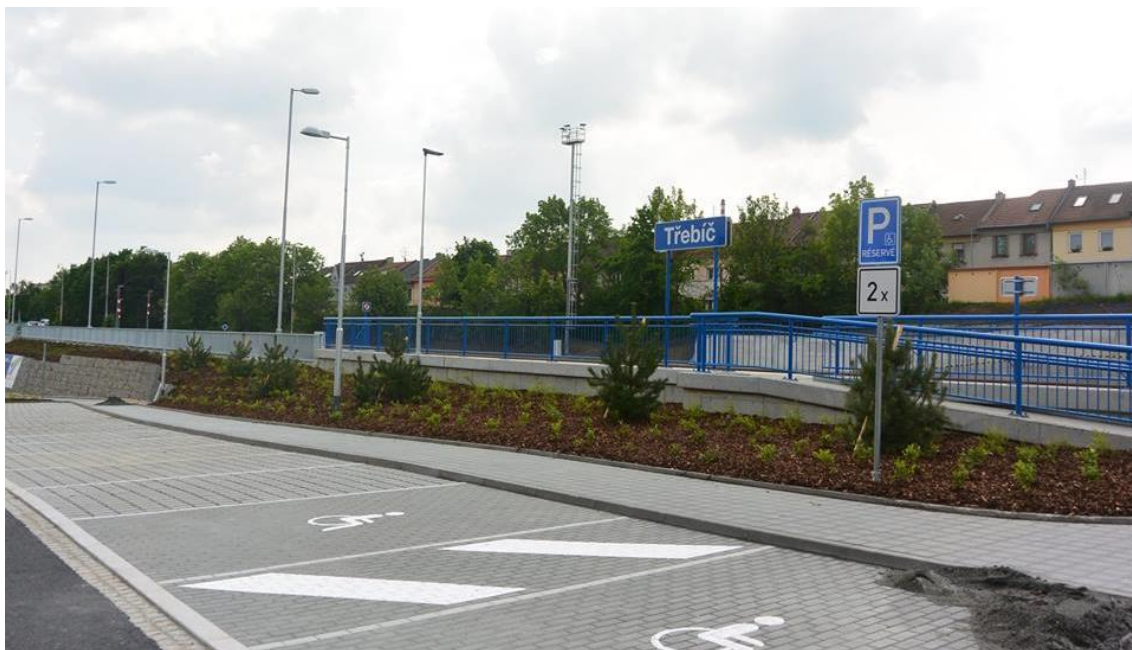
Obrázek 10: Prvky bezbariérového užívání přestupního terminálu – parkovací stání pro hendikepované
