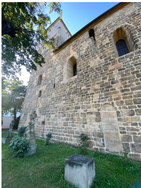
8. Kyje, kostel sv. Bartoloměje, pohled z jihu, polovina 13. století.
