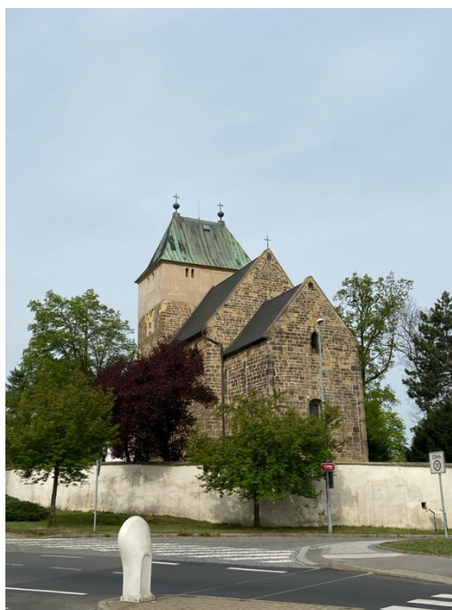
3. Kyje, kostel sv. Bartoloměje, pohled z jihu, první čtvrtina 13. století.
