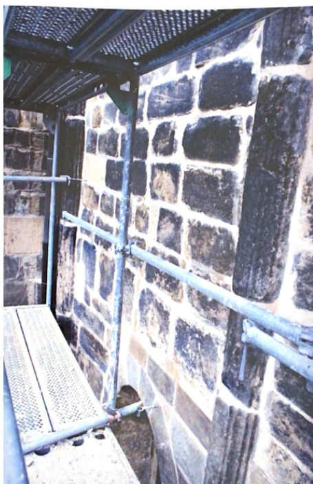
12. Kyje, kostel sv. Bartoloměje, restaurování kamenného pláště presbyteria, detail postihující nové zaspárování v oblasti
