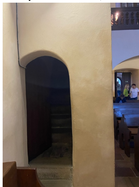
6. Kyje, kostel sv. Bartoloměje, hlavní loď – jižní vchod směřující k tribuně, 17. století.
