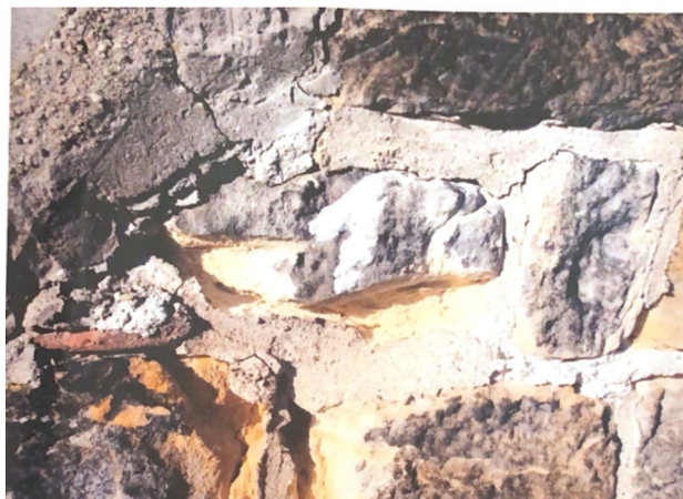
11. Kyje, Kostel sv. Bartoloměje, detail postihující původní stav kvádríkového zdiva východního štítu lodi.
