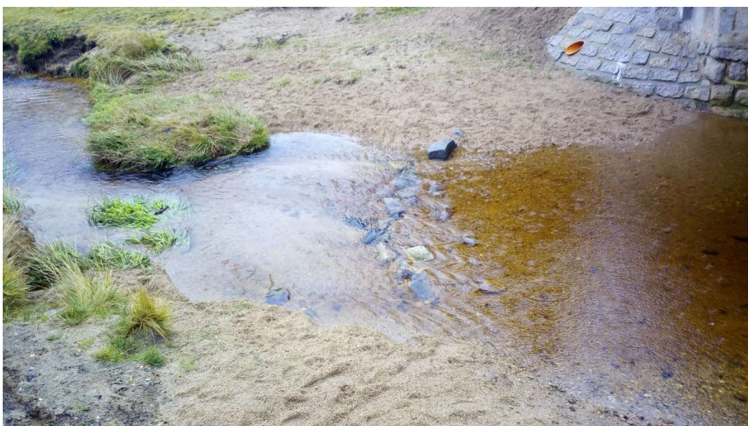
Obrázek 4: Lokalita 2: zúžení toku pod mostem vlivem sesunu břehu, vytváří se příčná hrubozrnná hráz, za ní vznikají čerňiny. Foto ze dne 19. listopadu 2020
