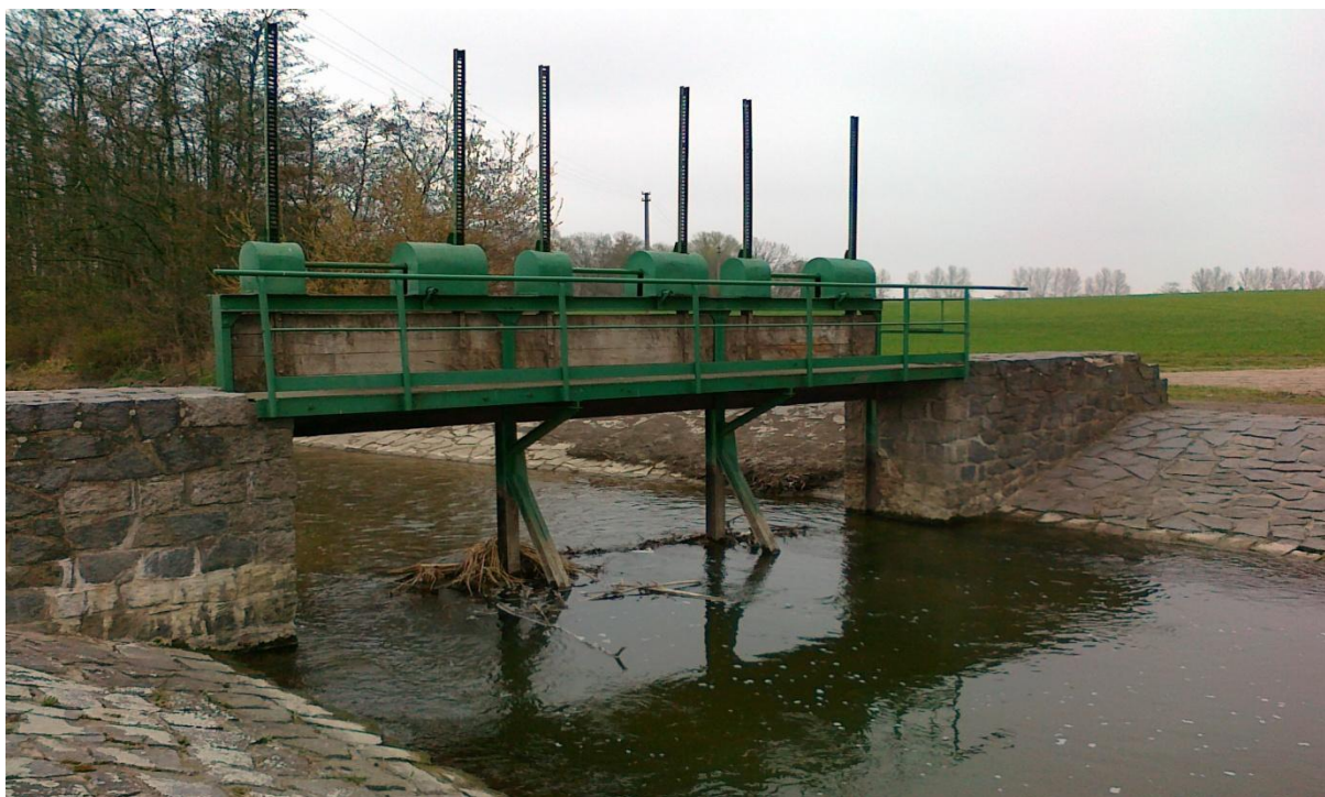
Obr 3. Betonové stavidlo před vtokem do Mydlovarského luhu
