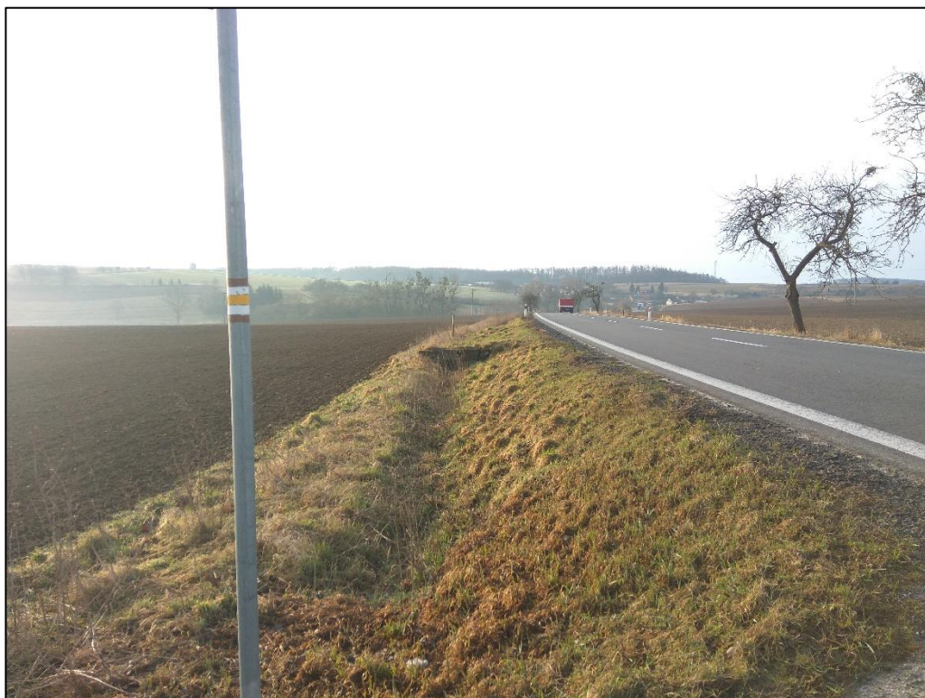
Obr. 33: Silniční násep silnice II/635 u Měníka (foto: L. Leibnerová, březen 2018).
