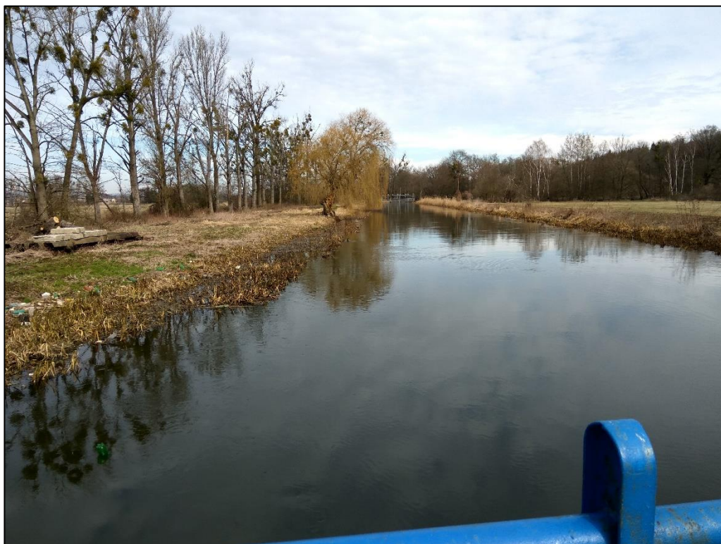
Obr. 31: Náhon vodní elektrárny Nové Mlýny (foto: L. Leibnerová, březen 2018).
