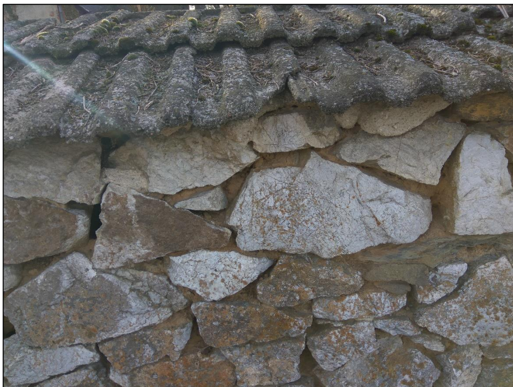
Obr. 35: Využití kamenů z Třesína při stavbě, kamenná zeď, Řimice (foto: L. Leibnerová, leden 2018).
