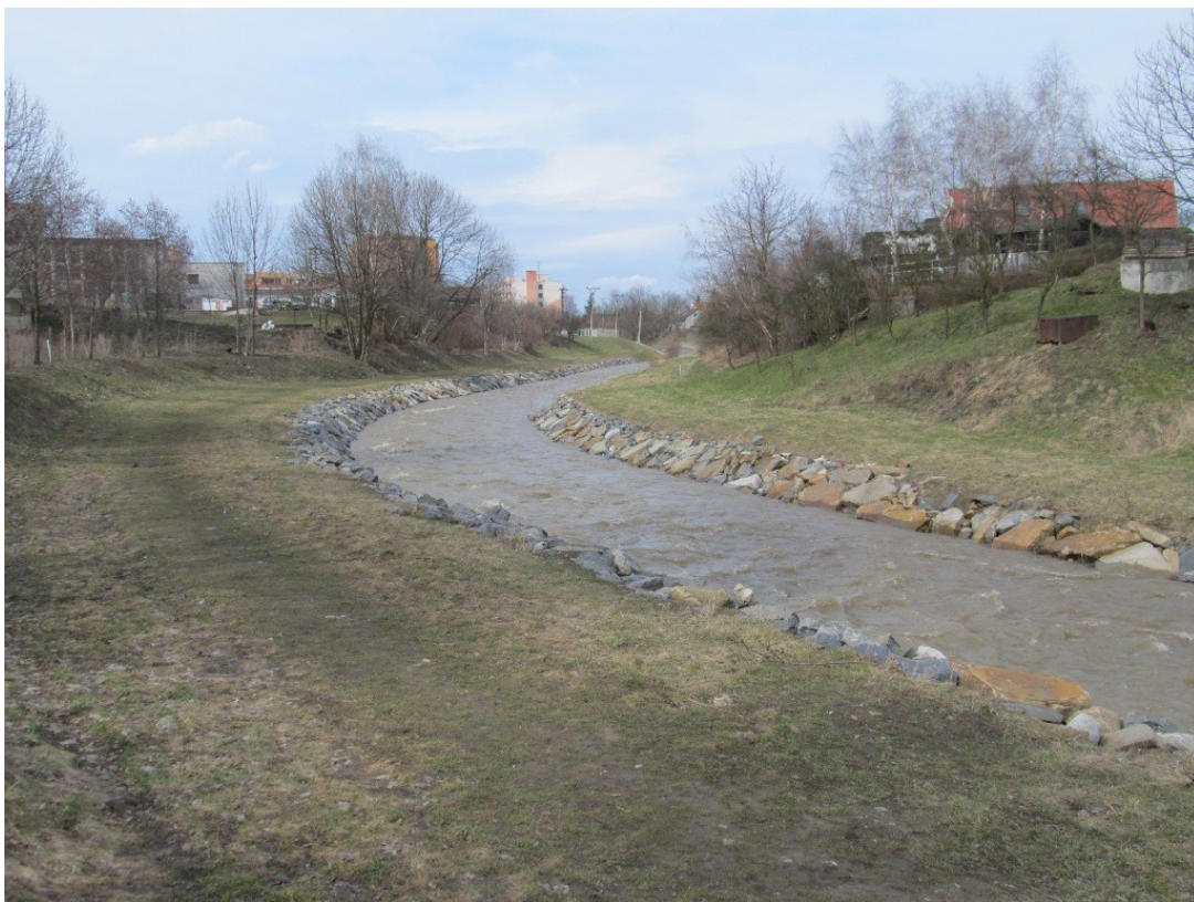
Příloha 22: Upravené koryto Jičínky v Novém Jičíně. (zdroj: vlastní foto)
