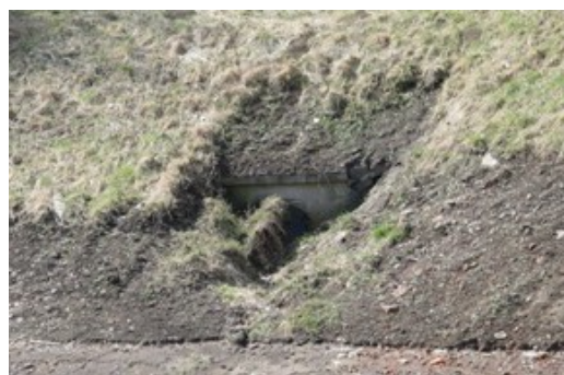
Obr. 19: Zanesená zpětná klapka
