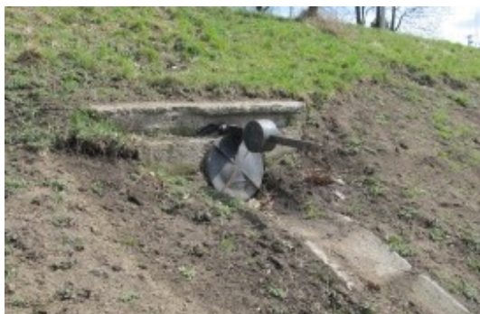
Obr.18: Funkční zpětná klapka
