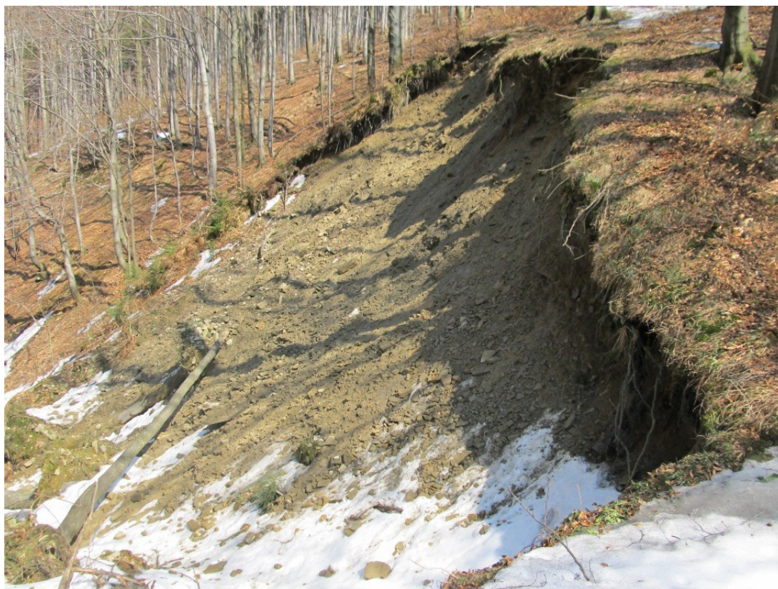
Obr. 12: Sesuv u splaveninové přehrážky na katastru obce Veřovice. (zdroj: vlastní foto)
