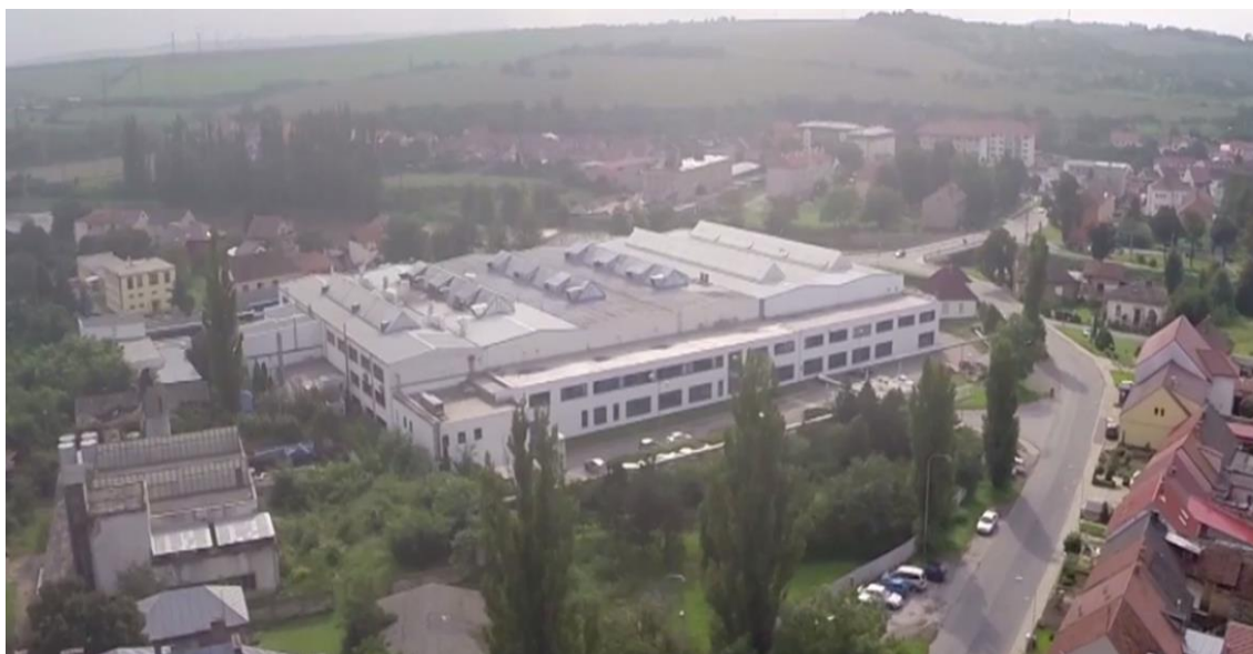
Obr. 3 Výrobní hala Metaldyne Oslavany (METALDYNE spol. s r.o., 2015)
