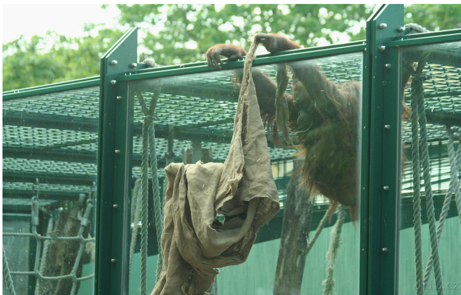
Obrázek 10: Ukázka zabezpečení venkovních prostor v zoologické zahradě ve Vídni. Skleněná bariéra zasazená do železné konstrukce, stropní bariéra tvořená pletivem ( http://www.jhl.cz/080502/slides/080502c173.html ).
