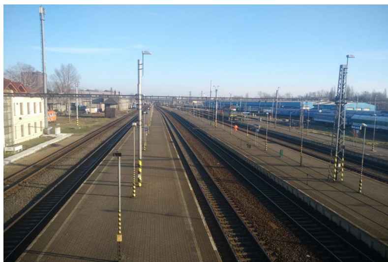
Obr č. 6: Železniční trať ve směru Karviná (Skokan, 12/2016)
