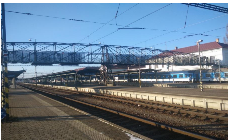
Obr č. 5: Ocelový lávka pro pěší - technická památka (Skokan, 12/2016)
