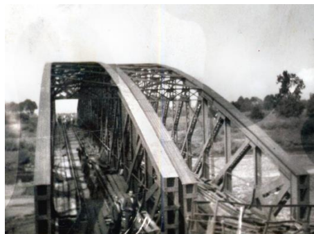
Obr. 11: Železniční most přes řeku Odru (zdroj: www.meandryodry.wz.cz, 2015)
