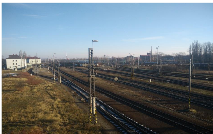
Obr. č. 2: Pohled na stanici Bohumín z železárenského mostu (Skokan, 12/2016)
