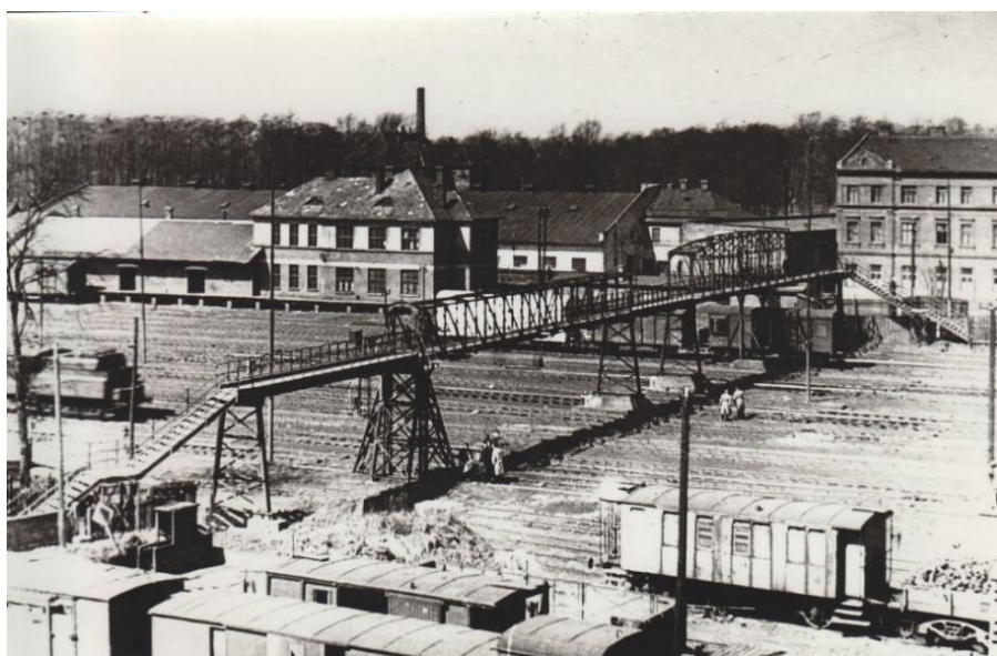
Obr. 17: Přechodná lávka na nádraží Košicko-bohumínské dráhy (zdroj: Železniční muzeum moravskoslezské, 2016)
