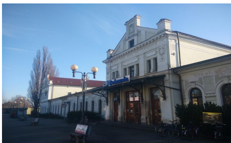
Obr. č. 3: Nádražní budova železniční stanice Bohumín (Skokan, 12/2016)
