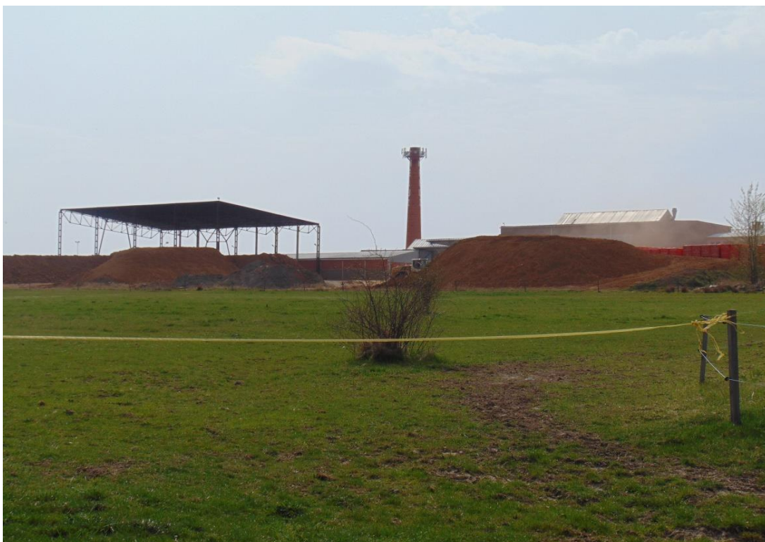
Foto č. 5 - Cihelna HELUZ Dolní Bukovsko
