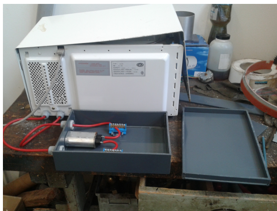
Obrázek 35: Vytažení kondenzátoru pomocí vysokonapěťových kabelů z MT.
