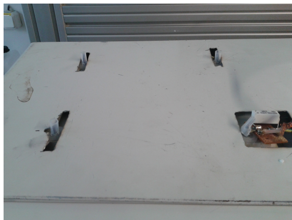
Obrázek 37: Upevnění kolektoru ke stropu MT.
