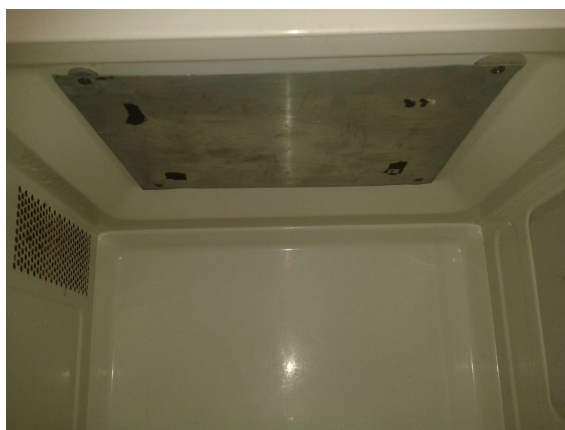
Obrázek 21: Kolektor upevněný ke stropu MT.
