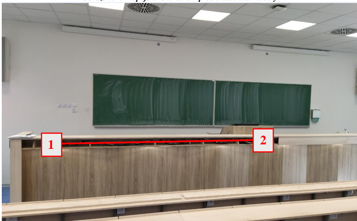
Obrázek 34: Propojení rekordéru – přední dutá část katedry
