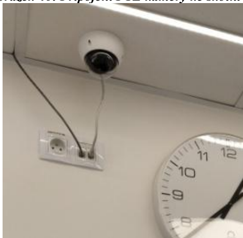
Obrázek 40: Připojení PTZ kamery ke školní síti
