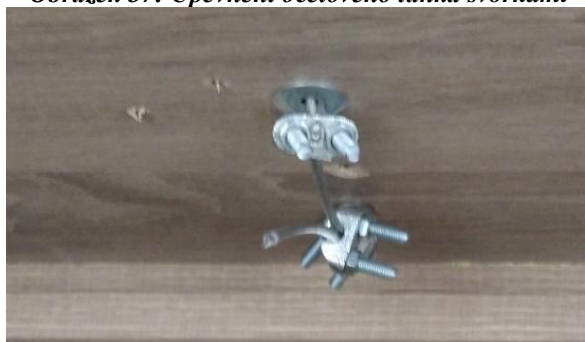
Obrázek 37: Upevnění ocelového lanka svorkami
