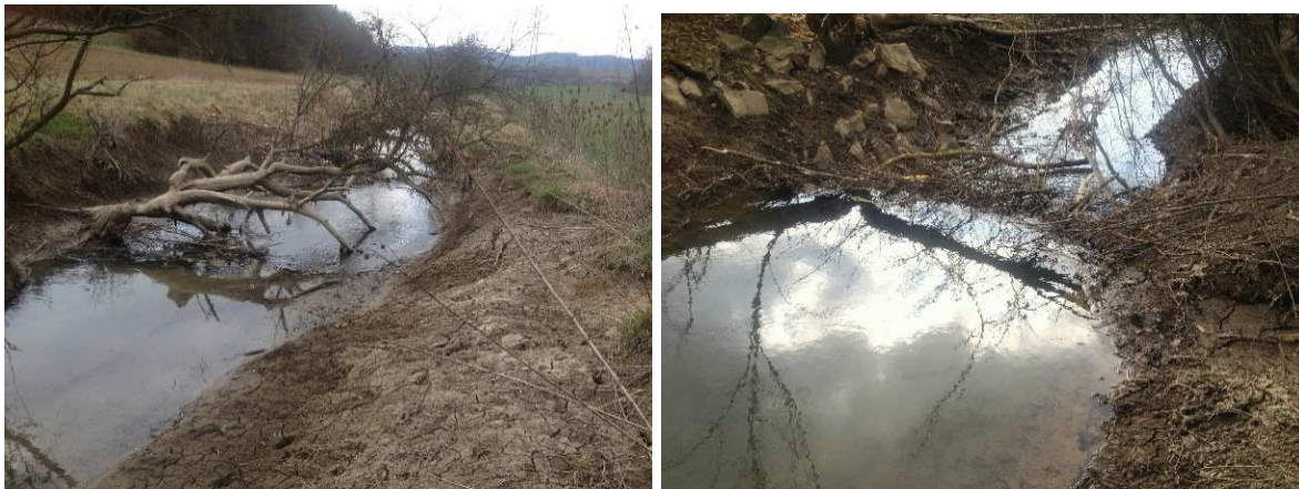
Obr. 2.2 Úsek č. 2 km 3,750 – km 3,961 (autor: Lucie Holá)
