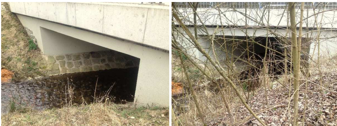
Obr. 2.3 Silniční most - km 2,969 (autor: Lucie Holá)
