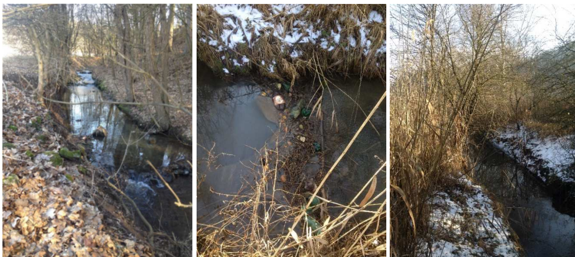
Obr. 2.1 Úsek č.1 km 2,778 – km 3,750 (autor: Lucie Holá)
