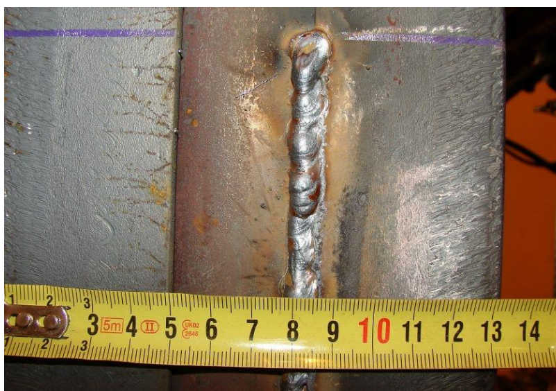
Obr. 5.16: Měření vzdálenosti, kde byla dosažena teplota 320 °C na pásnici U profilu pomocí termokřídly
