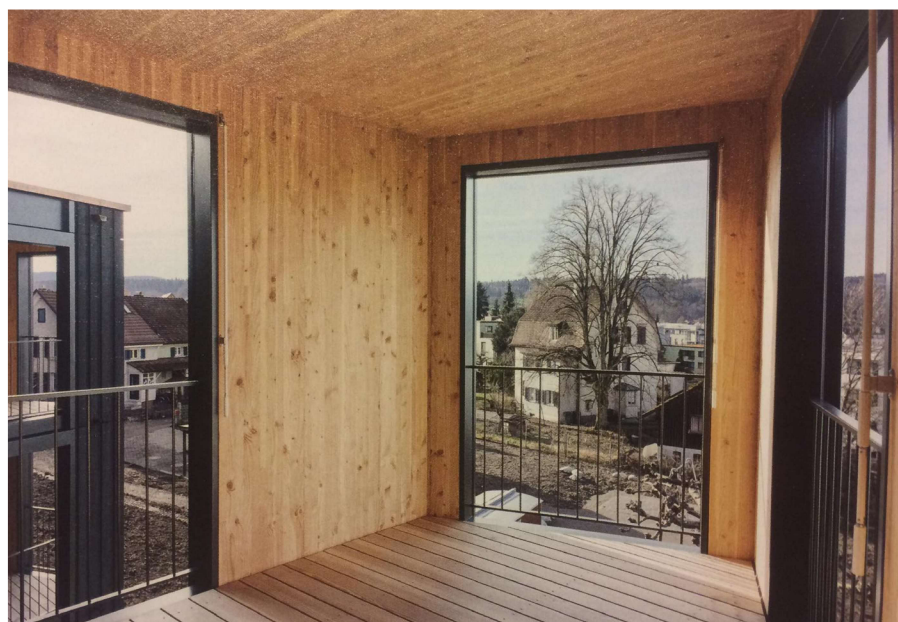
Obr. 9: Realizace z vrstveného panelu z interiéru (Gunßer, 2020)
