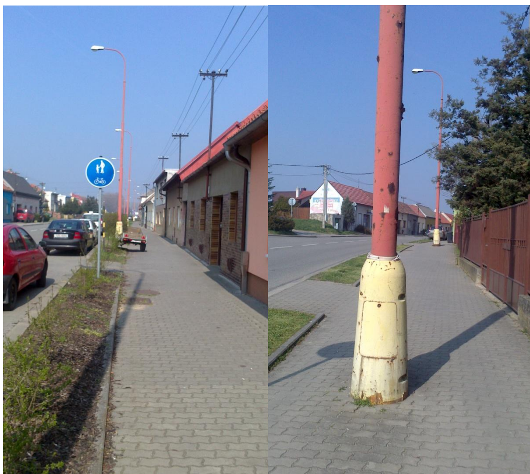
Obr 26 a 27. O pár desítek metrů je situace zcela jiná... a ve stezce ještě překážejí rozměrné sloupy veřejného osvětlení (Haničinec, 2014).
