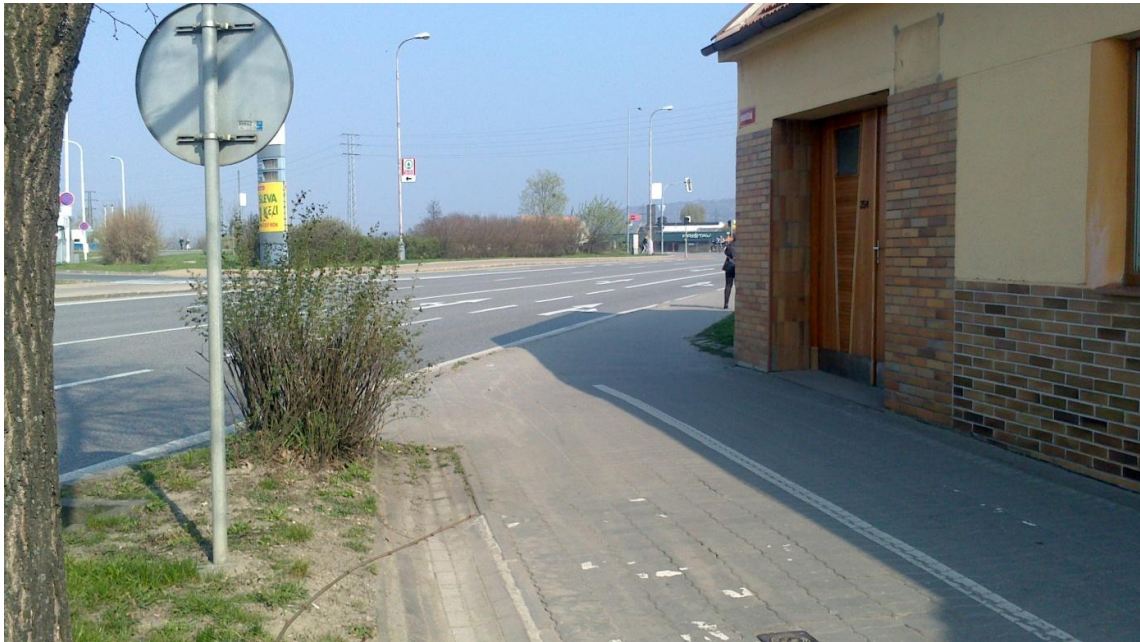
Obr 24. Jeden z nepřehledných úseků smíšené stezky (ulice Hradištská), která prochází celým Starým Městem, za zatáčku zde není vidět. Horizontální značení na povrchu komunikace, již není v nejlepším stavu a rozhodně nepříspěvá k bezpečnosti (Haničinec, 2014).
