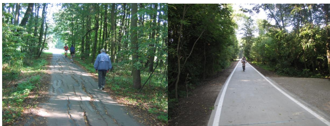
Obr 22. Cyklostezka Kunovickým lesem před a po rekonstrukci I. etapy (Hubáček, 2010).
