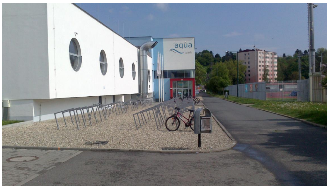
Obr 43. Moderní bezpečný typ stání pro kola je k nalezení už i v Uherském Hradišti. Zde snímek z ulice Sportovní, kde bylo parkování vybudováno v rámci rekonstrukce plaveckého bazénu, 04/2014 (Haničinec, 2014).
