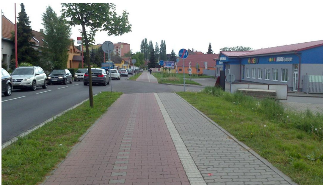
Obr 13. Spojení pro udržitelné druhy dopravy mezi Mařaticemi a Jarošovem zajišťuje tato společná stezka pro chodce a cyklisty s odděleným prostorem pro jednotlivé druhy dopravy, 04/2014 (Haničinec, 2014).
