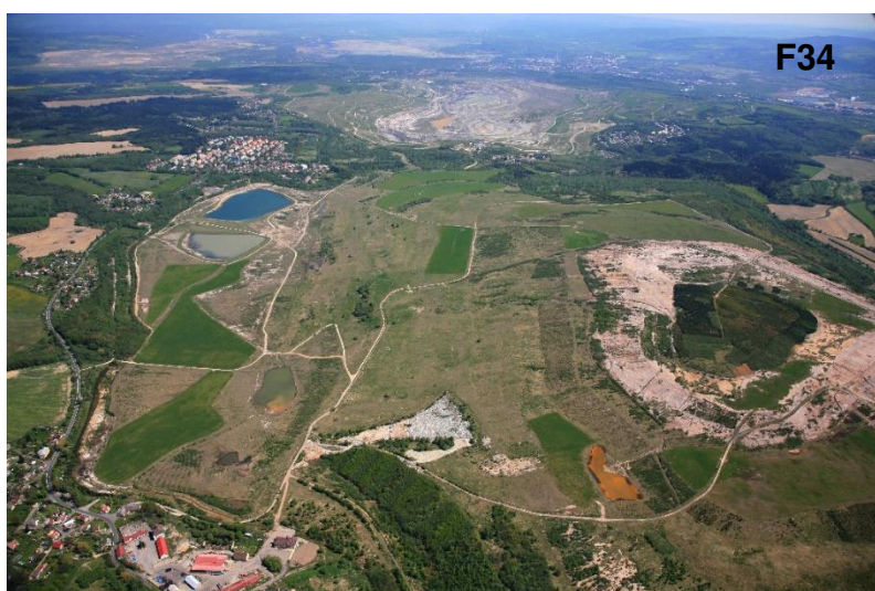
F34 - Výsypka Lítov v pohledu od západu k východu. Výsypka je již po lesnické i zemědělské rekultivaci. Na obrázku je patrné jak se změnilo původní uložení hornin. Vršek, horizont 559 m. n. m. byl překryt orníci a zalesněn, protože spodní fytotoxické vrstvy z lomu Libík se dostaly na vrchol výsypky. Horizont 544 m. n. m. pod ním je bez překrytí orníci nerekulovatelný, ostatní spodní horizonty 539 m. n. m. a nižší jsou tvořeny cyprisovými jíly, které se původně nacházely ve vrchních pozicích těžby lomu Libík (SPA SU a.s.)
