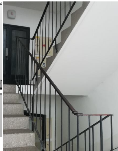
Obr. 117 Reálné zábradlí v panelovém domě
