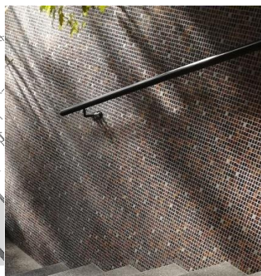
Obr. 103 Reálné zábradlí u přímého schodiště
