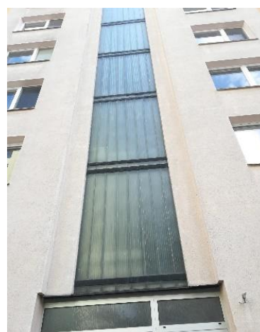
Obr. 29 Reálný skleněný plášť panelového domu
