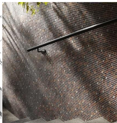
Obr. 103 Reálné zábradlí u přímého schodiště
