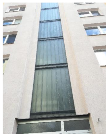
Obr. 29 Reálný skleněný plášť panelového domu
