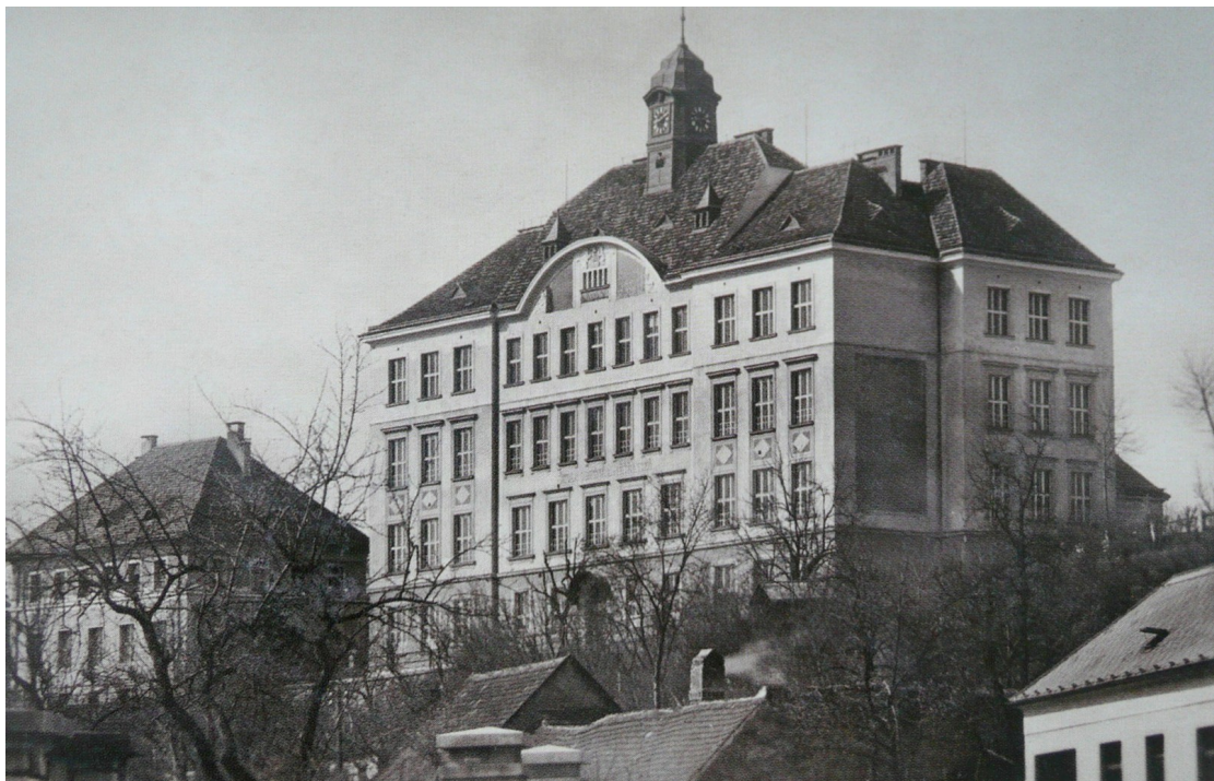
Obr. 17: školní budova a opatrovna, 1938
