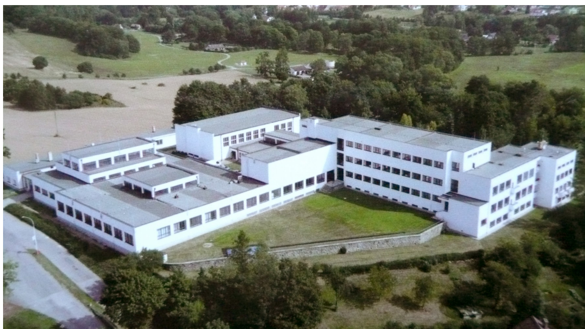
Obr. 8: Budova průmyslové školy od roku 1933 čp. 440, celkový pohled
