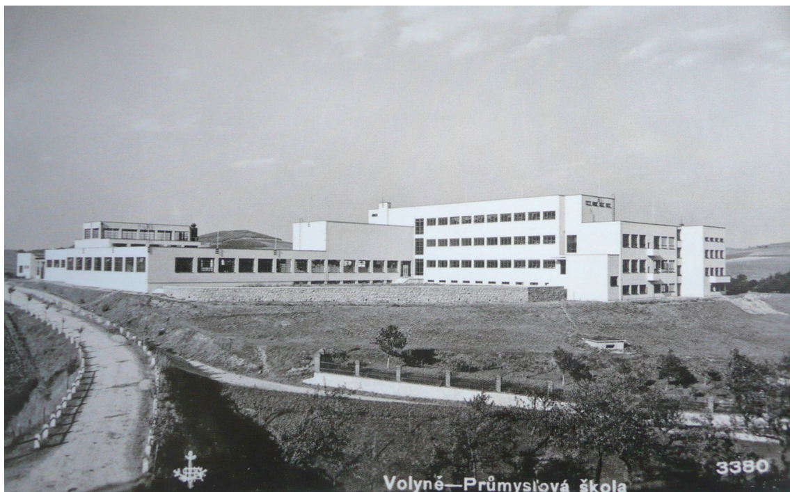
Obr. 19: Novostavba zemské průmyslové školy, 1933
