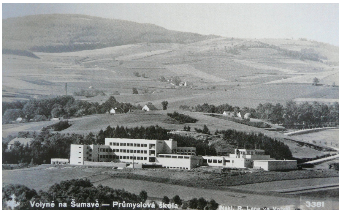
Obr. 20: Novostavba zemské průmyslové školy, 1936
