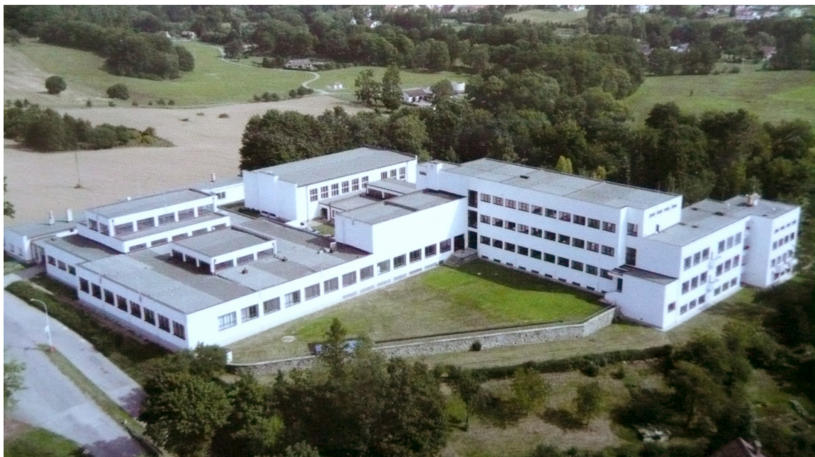
Obr. 8: Budova průmyslové školy od roku 1933 čp. 440, celkový pohled
