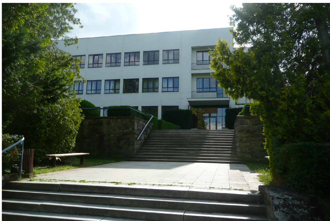
Obr. 6: Budova průmyslové školy od roku 1933 čp. 440, přední pohled
