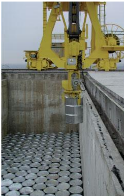
Obr. 8: Zakládání sudu do jímky v Dukovanech (67)
