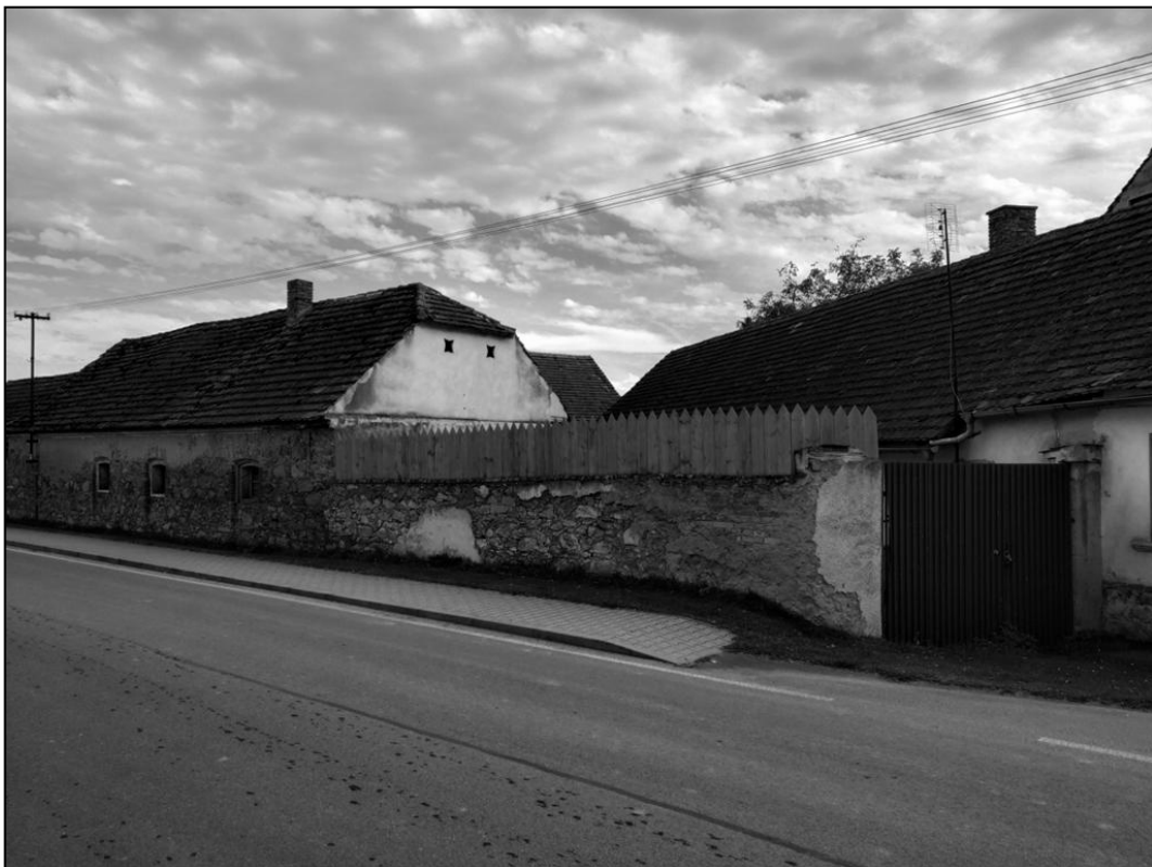
Selská usedlost čp. 10 v Kestřanech (říjen 2019).
