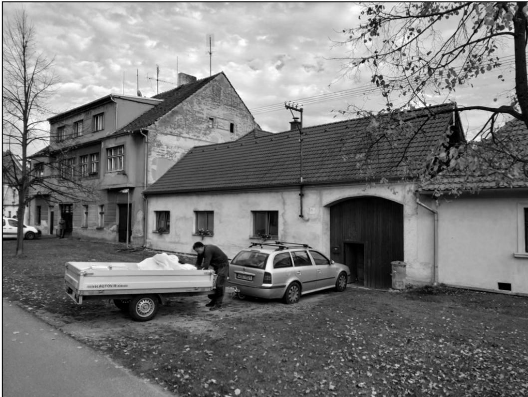
Selská usedlost čp. 18 v Kestřanech (říjen 2019).
