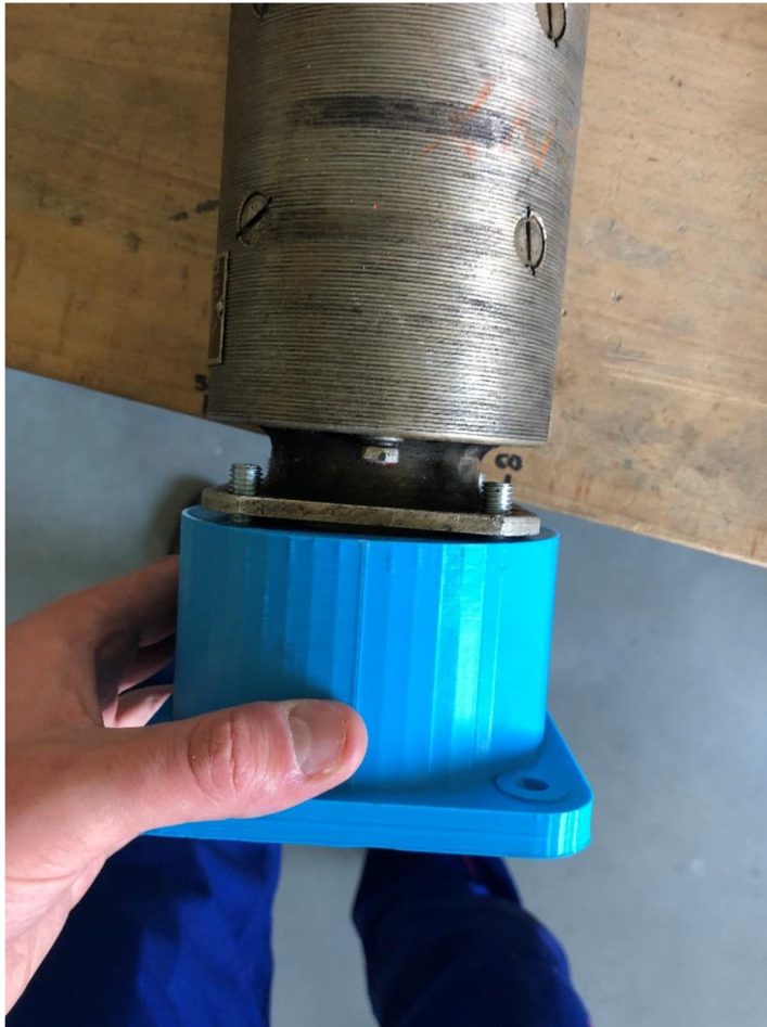
Obrázek 12 - Instalace příruby na dynamo
