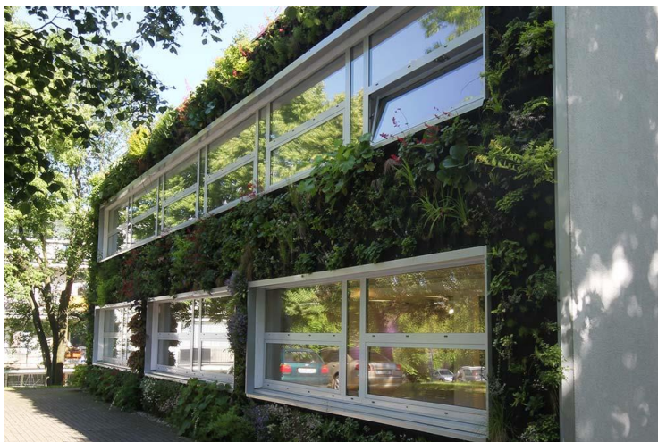
Obrázek 7 Vertikální stěna vytvořená na principu modulárního kazetového systému od firmy Němec s.r.o. - Luxusní povrchy & Kaskádové zahrady Zdroj: https://cascadegarden.nemec.eu/kontakt
