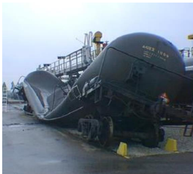
Obrázek 5.12 Ztráta stability skořepinové konstrukce
