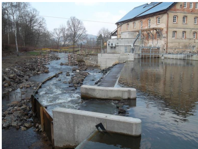
Obr.20 MVE Stružnice (vlastní)
