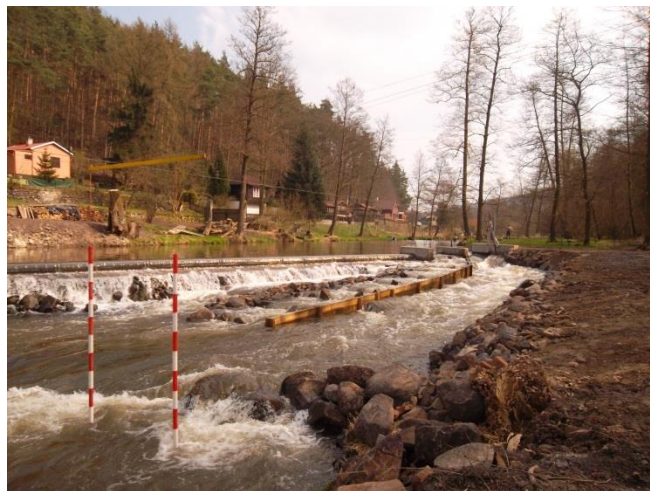
Obr.18 MVE Stružnice, těleso jezu, rybí přechod, sportovní propust(vlastní)
