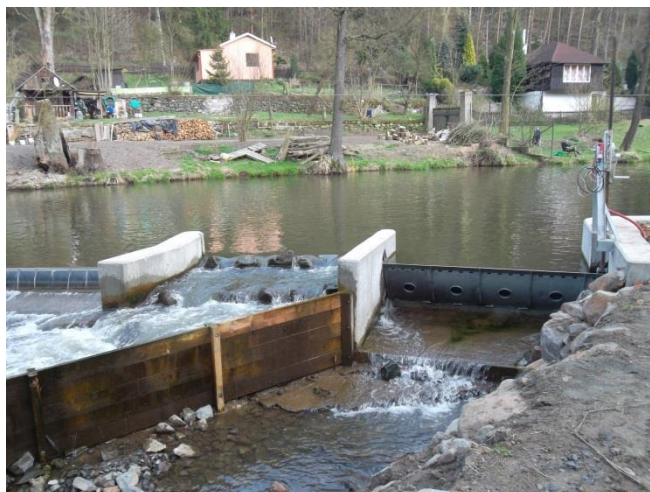
Obr.19 MVE Stružnice, detail rybího přechodu a klapky sportovní propusti (vlastní)
