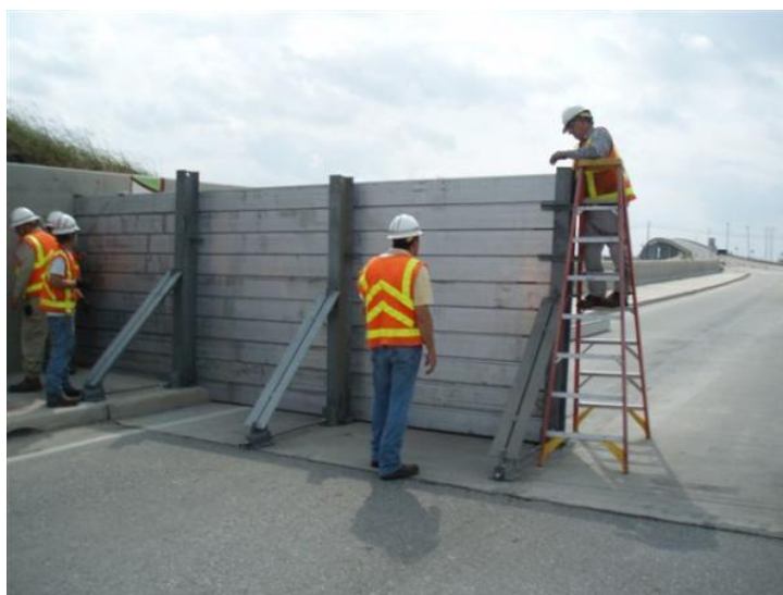
Obr.1 Montáž mobilního hrazení (Flood Control America 2013)
