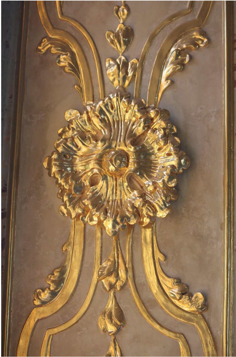
Obr. 64 Bývalá opatova kaple, štukový dekor zdobící ostění oken (detail), Antonio Ricca, zlacený štuk, 1727, bývalá premonstrátská kanonie Hradisko u Olomouce.
