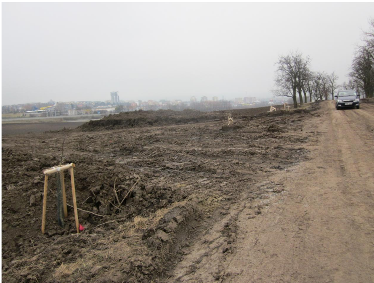
Obr. 29: Poškozená mladá výsadba ve VKP Hrušňová alej. Autor Štěpánková J., 9. 4. 2013.
