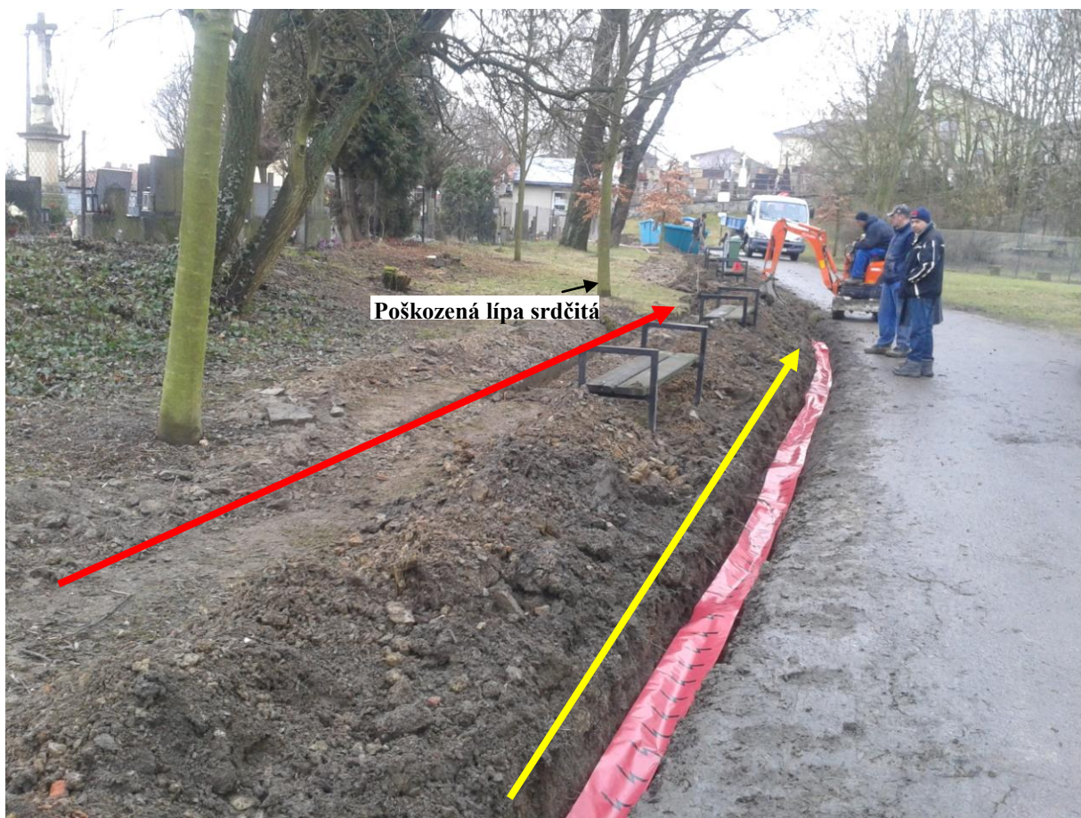
Obr. 18: Zobrazení stávajícího (znázorněno žlutě) a původního (znázorněno červeně) výkopu na mapě. Autor Richterová P., 12. 2. 2014.
