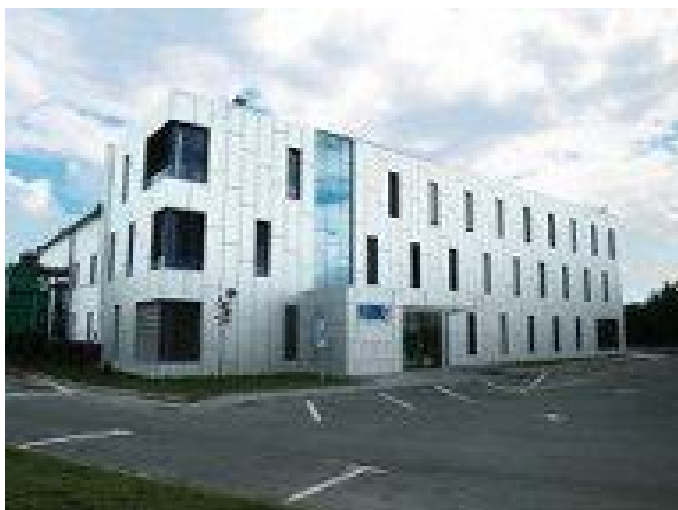
Foto č. 6 – HDO spol. s r.o.
