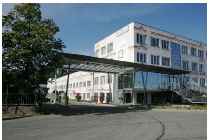
Foto č. 4 – Klein & Blažek, s.r.o. Štíty
