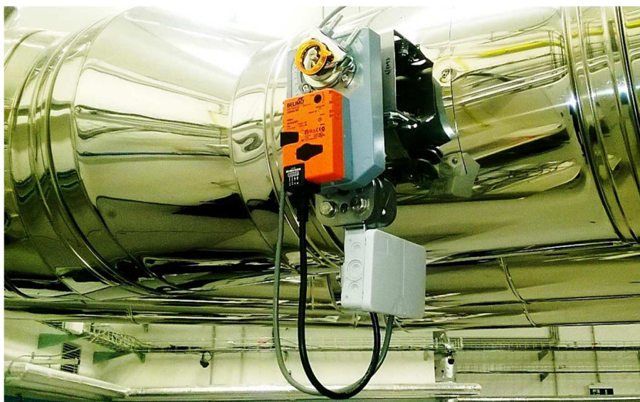
Obr. 28 Spalinová škrticí klapka se servomotorem [26]
